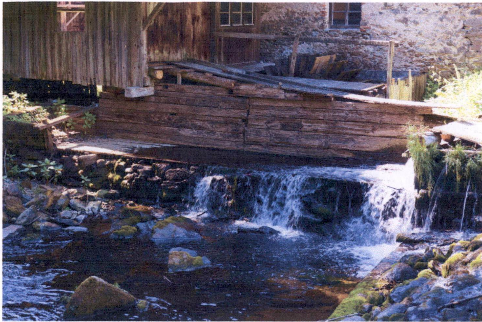
Abbildung 11: reduzierter Abfluss bei angenommenem Niedrigwasser im Juni 2014 über die Zuleitung zu den Wasserrädern
