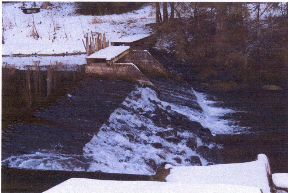
Abbildung 8: Abfluss über das Wehr bei erhöhter Wasserführung im Februar 2014
