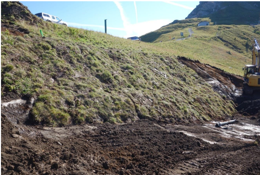
Abb. 22: Wiedereingebaute Rasenziegel in einer Böschung (Beispielbilder: Dietmann)
