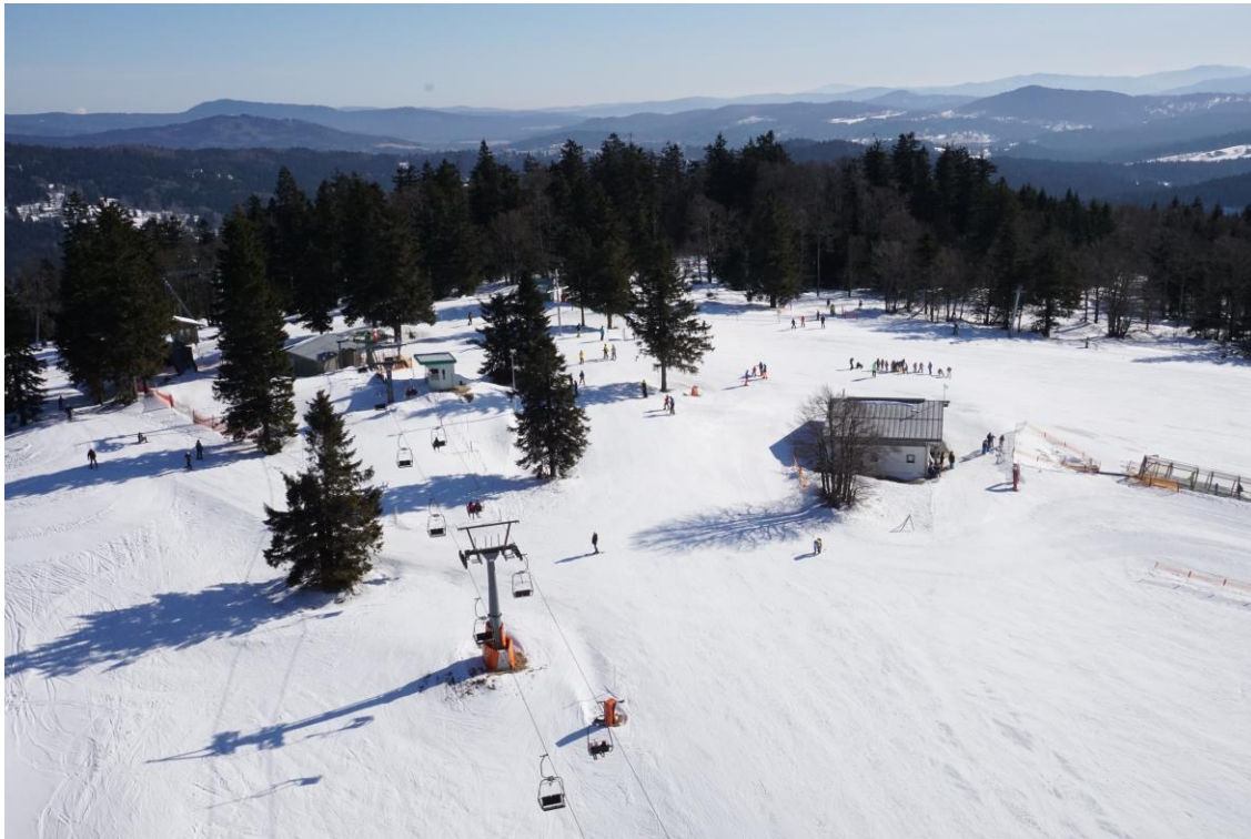
Abb. 6: Drohnenfoto des Bergstationsbereichs im Ist-Zustand.
