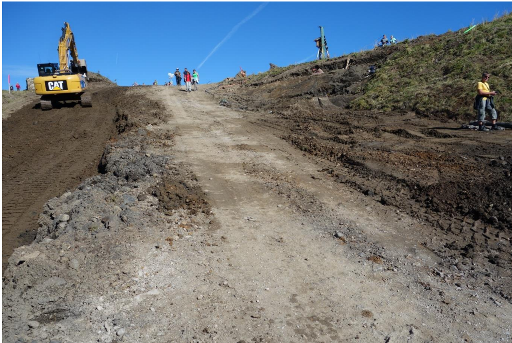
Abb. 19: Konsequente "Rasenziegelmethode": die Rasenziegel werden ausgebaut (linke Bildhälfte) und nach möglichst kurzer Zwischenlagerung wieder eingebaut (rechte Bildhälfte in der Böschung).
