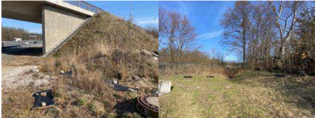
Abb. 35: Ruderale Verkehrsnebenfläche bei der Überführung Fischbacher Hauptstraße
