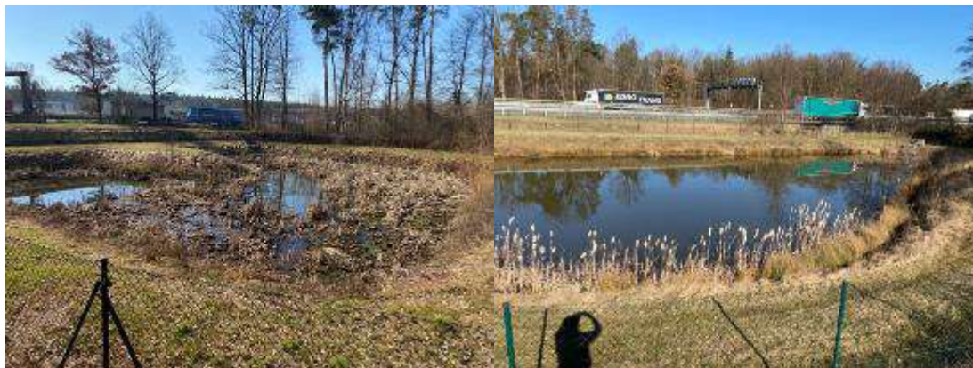
Abb. 43: Regenrückhaltebecken westlich der BAB A9
