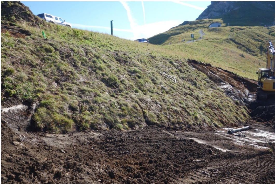
Abb. 19: Wiedereingebaute Rasenziegel in einer Böschung (Beispielbilder: Dietmann)
