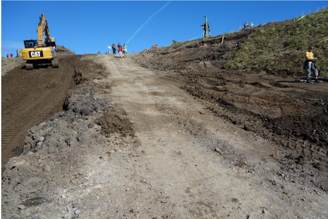
Abb. 18: Konsequente "Rasenziegelmethode": die Rasenziegel werden ausgebaut (linke Bildhälfte) und nach möglichst kurzer Zwischenlagerung wieder eingebaut (rechte Bildhälfte in der Böschung).
