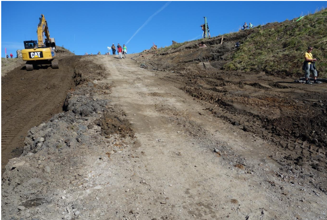
Abb. 16: Konsequente "Rasenziegelmethode": die Rasenziegel werden ausgebaut (linke Bildhälfte) und nach möglichst kurzer Zwischenlagerung wieder eingebaut (rechte Bildhälfte in der Böschung).
