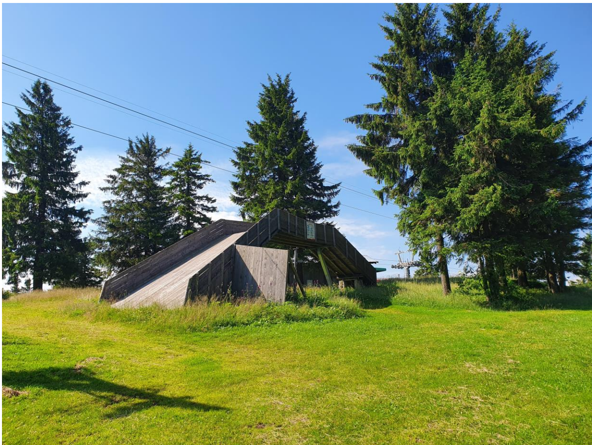
Abb. 7: Geplanter Standort der Bergstation der 4er-Sesselbahn im Bereich der vorhandenen Bügelrampe; diese wird abgebaut.
