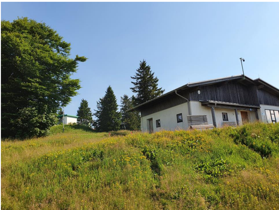
Abb. 14: Bestehendes Betriebsgebäude mit ausreichend öffentlichen WC-Anlagen.
