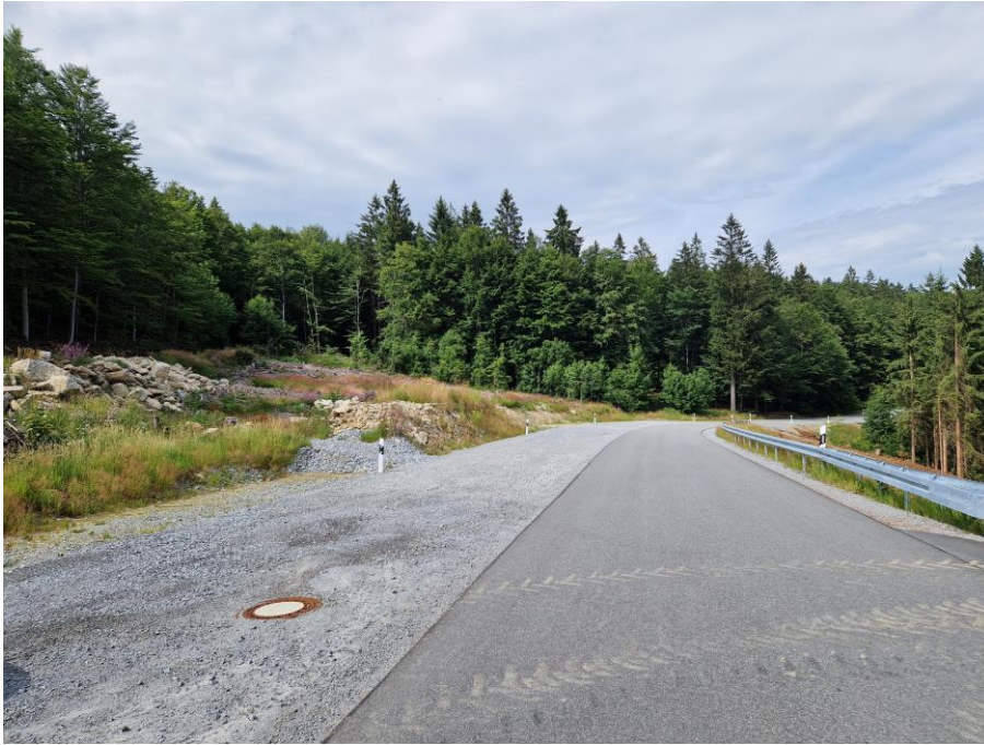
Abb. 13: In diesem Parkplatzbereich ist der Zusammenbau der Seilbahnstützen vorgesehen.
