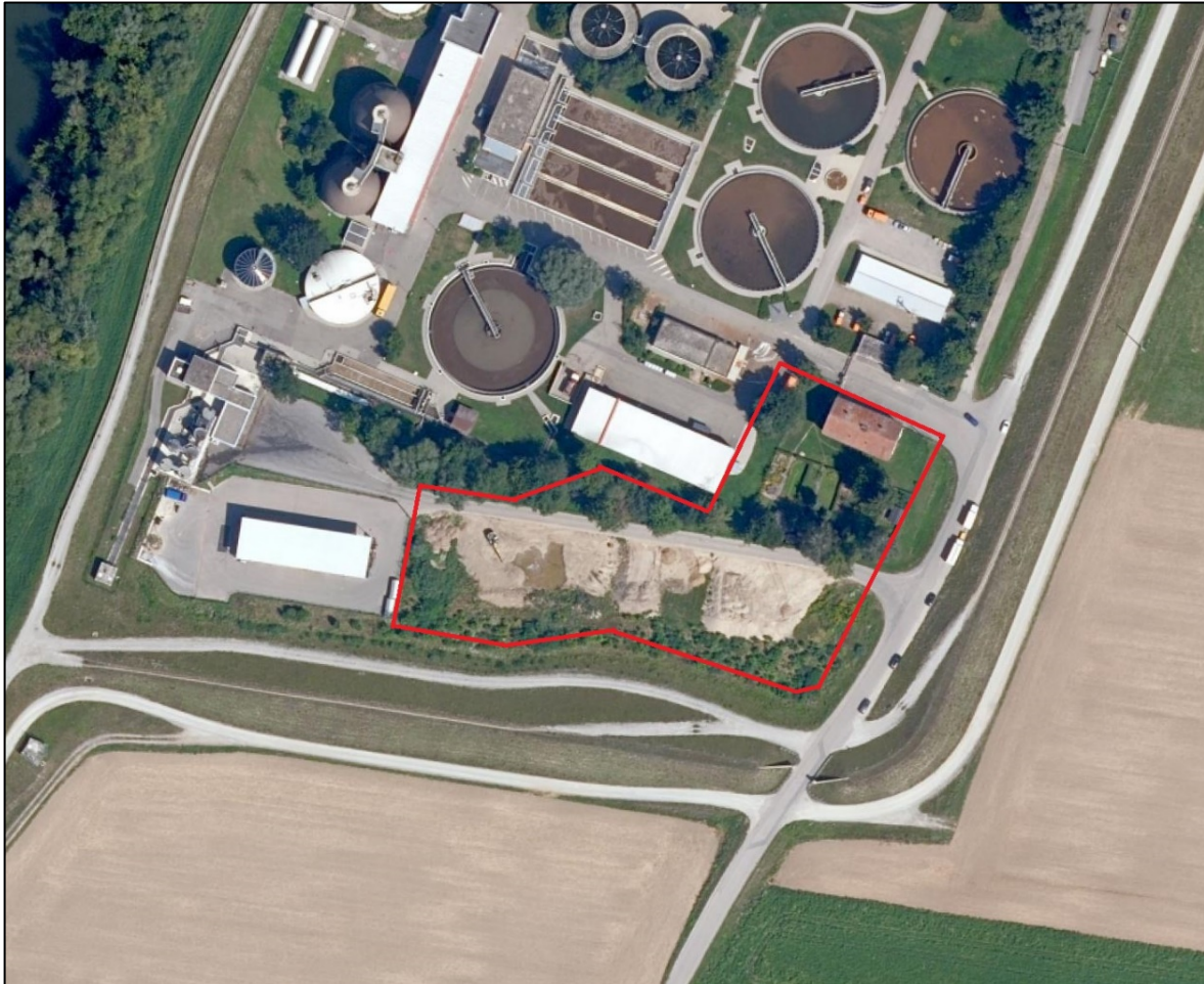
Abbildung 2: Luftbild des Standorts, geplante Fläche der KVA Straubing
