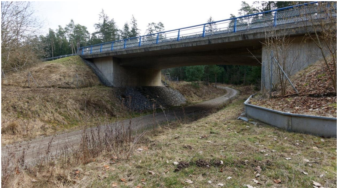
Abb. 4: Brücke B 16 über den Taubenweg von Norden
