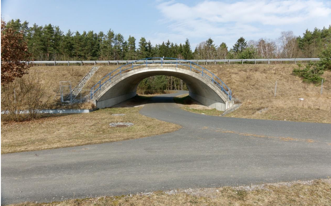
Abb. 6: Brücke B 16 über GVS Fuchsenweiherweg von Süden
