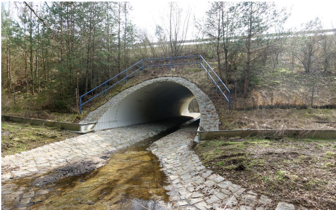
Abb. 5: Durchlass des Kaltenbaches unter der B 16 von Norden
