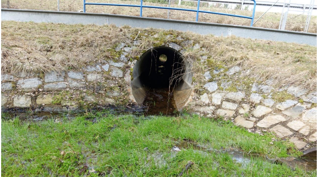
Abb. 3: Durchlass Schellnweiher Bach unter B 16 von Süden
