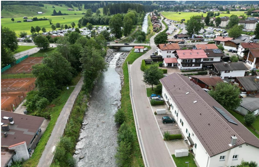
Abbildung 12: Begradigter, kanalartiger Abflussquerschnitt mit fischpassierbar ausgeführter Rampe (ITS Scheiber ZT GmbH, 2023)
