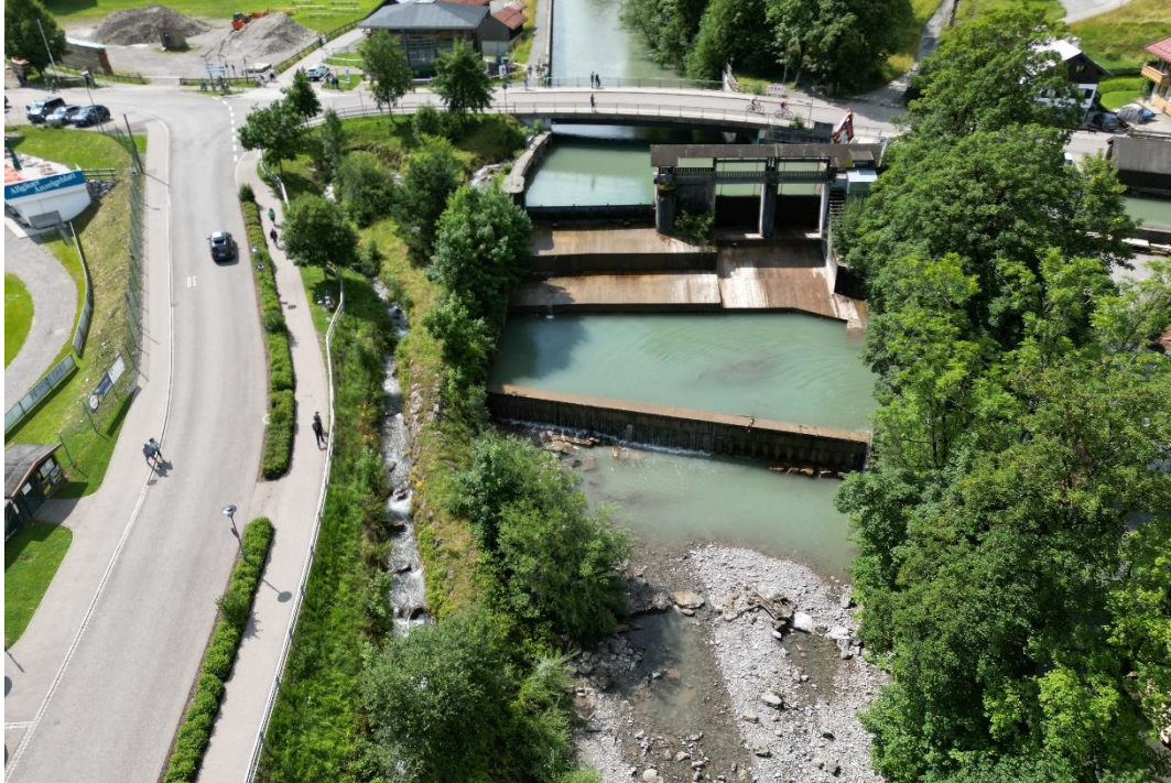
Abbildung 9: Ausleitungskraftwerk mit fischpassierbarem Umgehungsgerinne am Beginn des Siedlungsgebiets von Oberstdorf (ITS Scheiber ZT GmbH, 2023)
