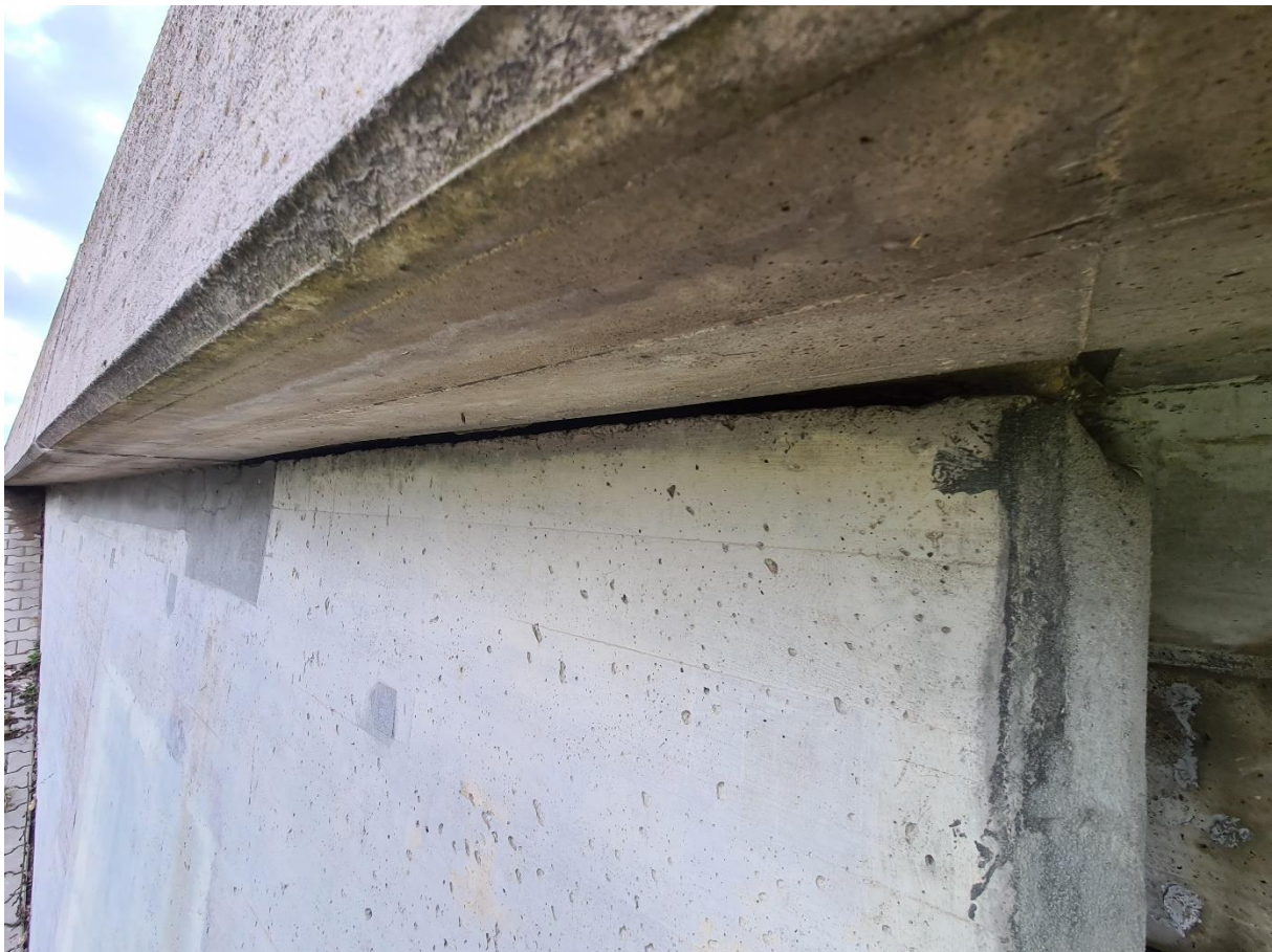
Abbildung 7: Weitere Struktur (horizontal) an der Südseite des westlichen Bauwerks, die für Fledermäuse als Spaltenquartier geeignet erscheint (April 2022).
