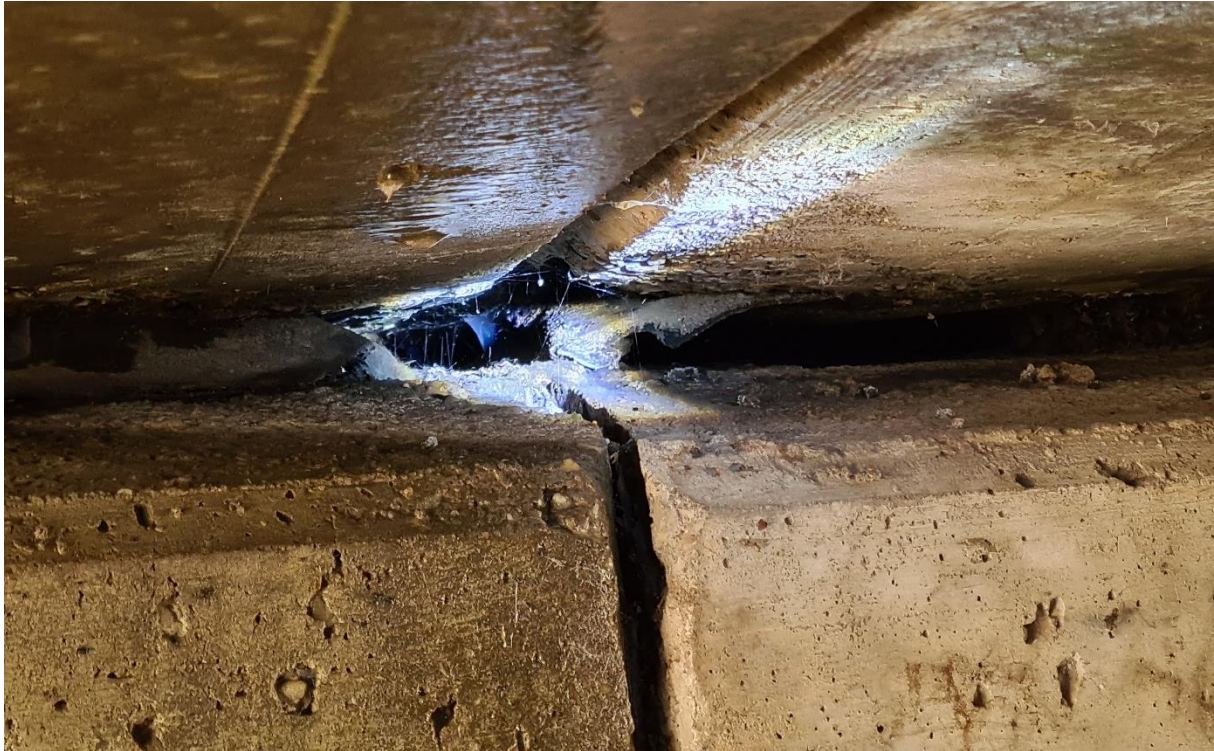
Abbildung 6: In der Mitte des westlichen Bauwerks, auf der westlichen Seite: hier reicht der Hohlraum weiter in das Bauwerk (April 2022).
