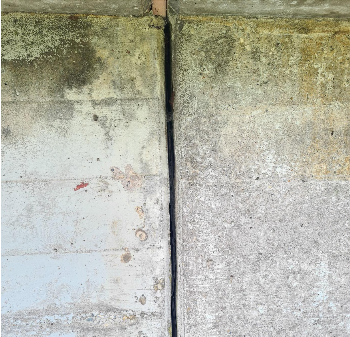
Abbildung 3: Spaltstruktur (Dehnungsfuge) am westlichen Bauwerk aus der Nähe betrachtet (April 2022).
