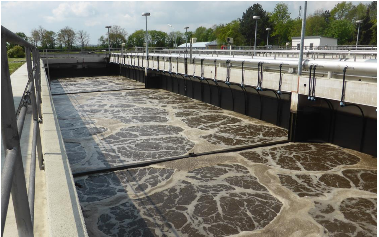
Foto 5.2-7: Nitrifikation im Norden / Vorklärbecken (vgl. Nr. 7 Abbildung 5.2-1)
