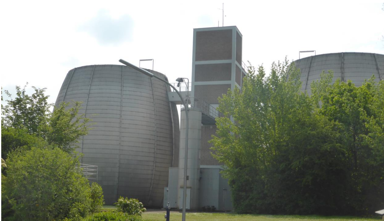
Foto 5.2-9: Faulbehälter (vgl. Nr. 12 Abbildung 5.2-1)
