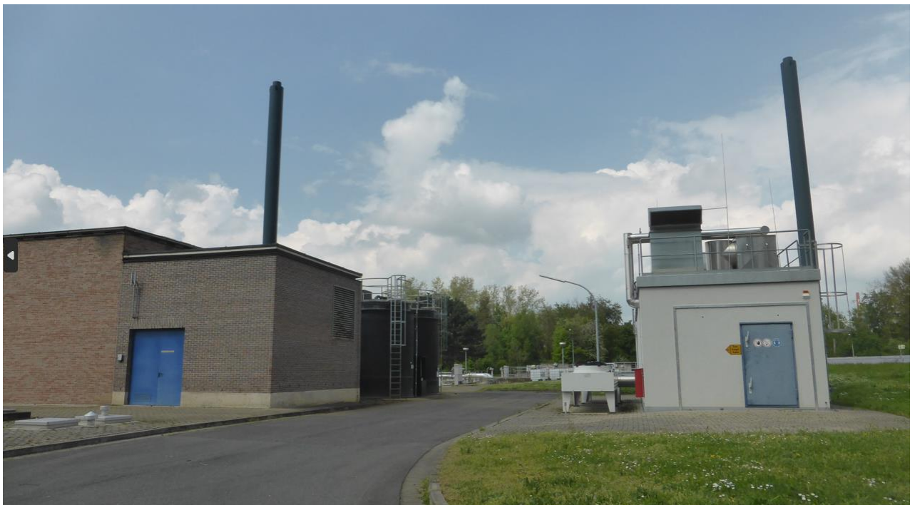
Foto 5.2-6: BHKW (rechts) und Energiezentrale (links) (vgl. Nr. 15 und 16 Abbildung 5.2-1)
