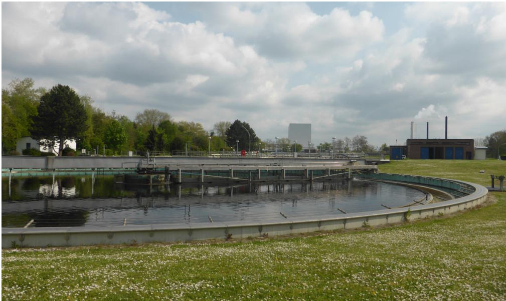
Foto 1: Blick auf das Nachklärbecken
