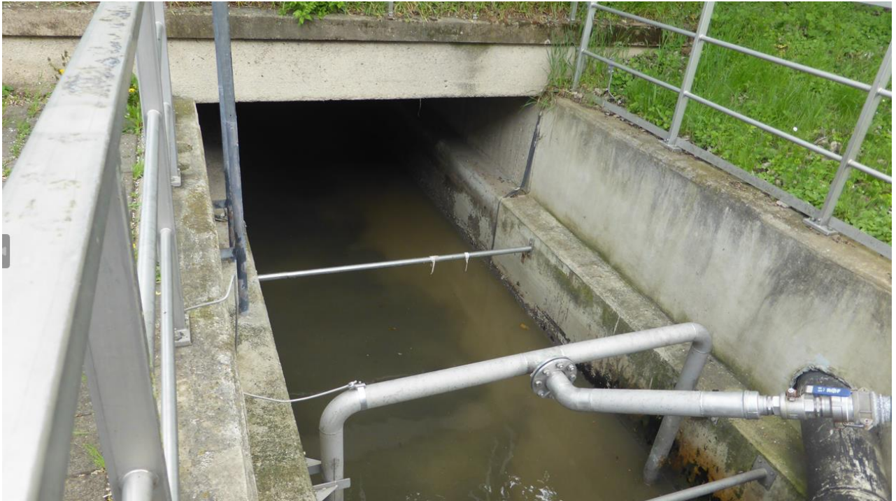
Foto 5.2-1: Abwasserzulauf im Südosten
