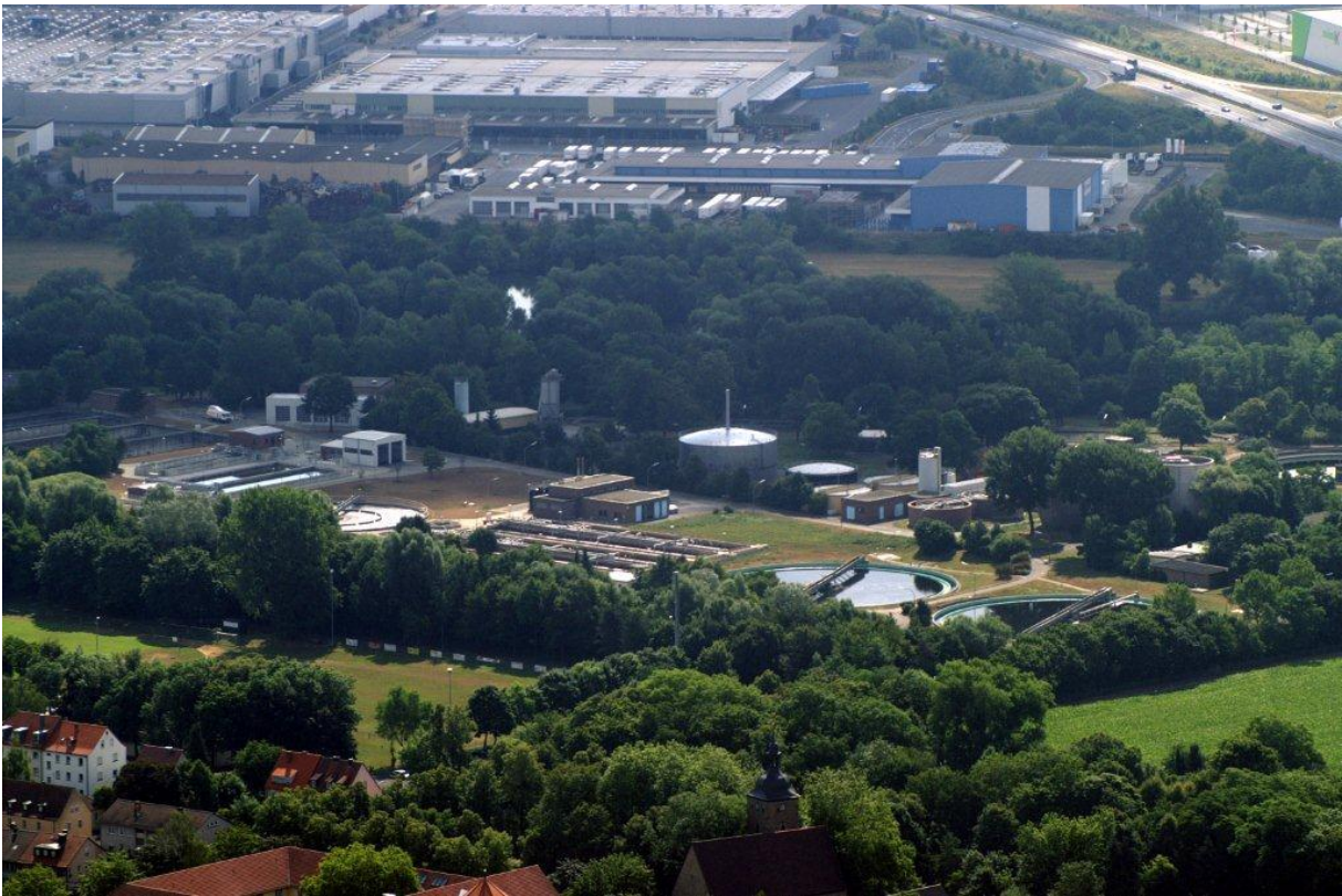
Foto 6.7-1: Blick auf das Klärwerk aus Westen
