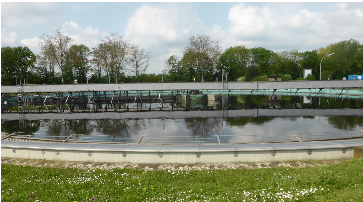
Foto 5.2-10: Nachklärbecken im Nordwesten (vgl. Nr. 8 Abbildung 5.2-1)
