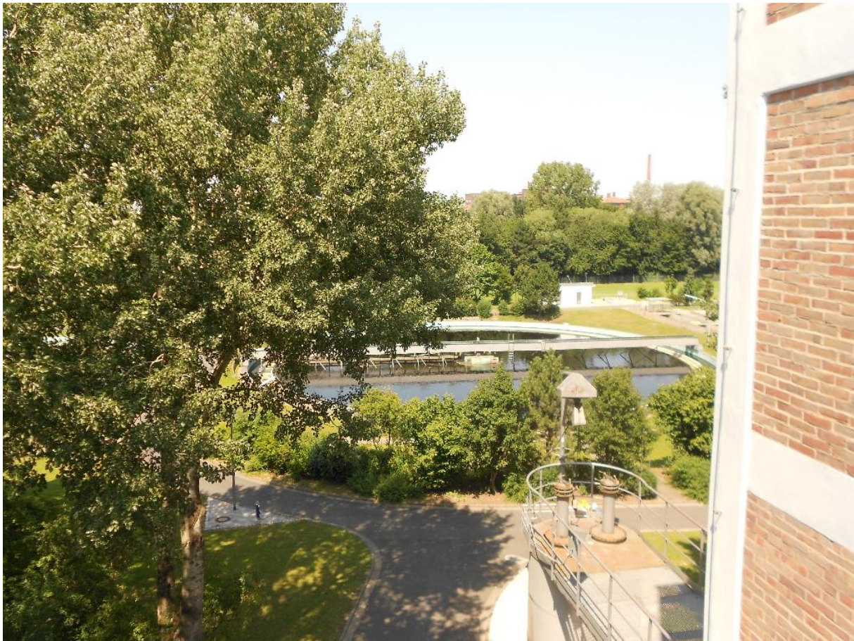
Foto 6.7-3: Blick vom westlichen Faulturm auf das östliche Nachklärbecken Richtung Norden
