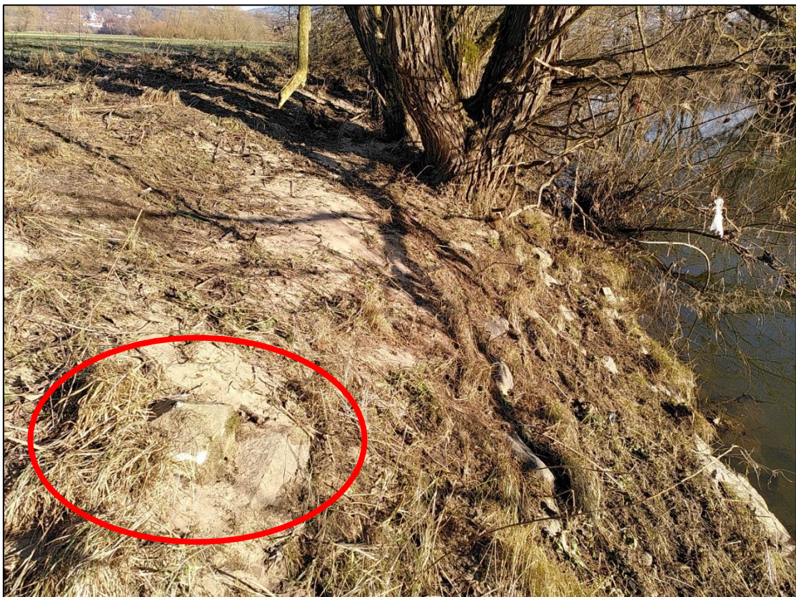
Blick auf das Baufeld des geplanten Anschlussgrabens von Westen, Kilometerstein im versteinten Böschungsbereich des Prallufers
