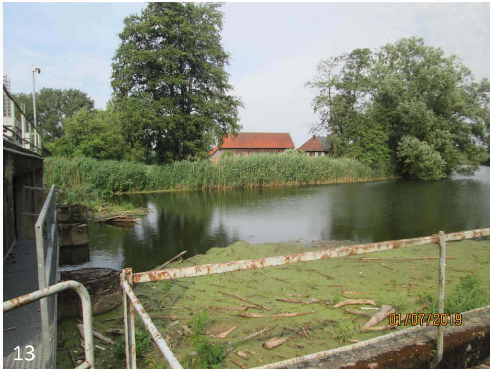
Blick vom Main-Wehr auf die Rothwinder Mühle
