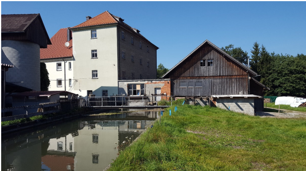
Abbildung 7: Mühlkanal in der Ortslage von Sontheim
