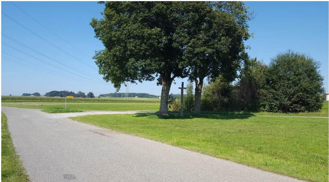
Um eine ausreichende Entwicklungslänge bei einem maximalen Längsgefälle von 10 % zu erhalten und gleichzeitig die Situation am bestehenden Kreuz (Abbildung 11) nicht zu beeinträchtigen, muss der Weg in seiner Lage etwas nach Osten verschoben werden.
