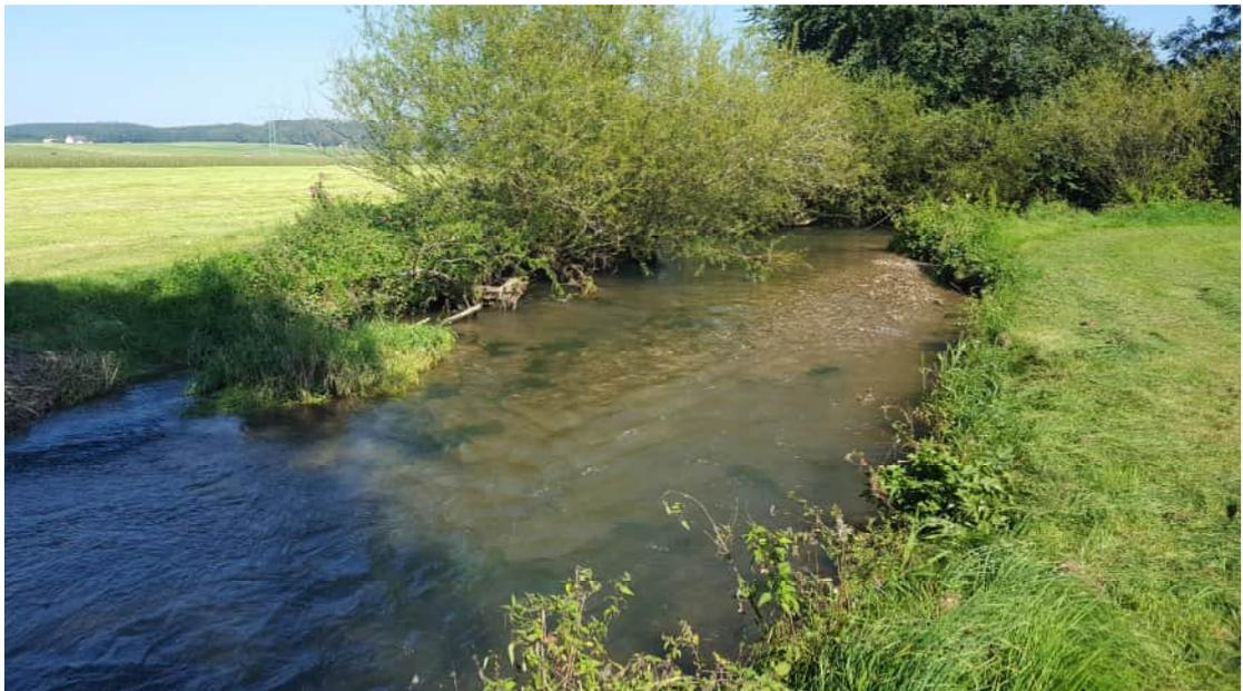
Innerhalb des Planungsbereichs liegt die Gewässersohle der Östlichen Günz im Schnitt nur rund einen Meter unter dem Gelände. Bereichsweise sind uferbegleitende Wälle vorhanden. Die Sohlbreite variiert und beträgt im Bereich des geplanten Durchlassbauwerks ca. 6 m.
