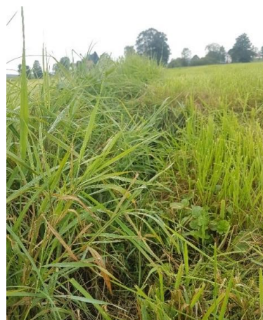
Abbildung 10: Entwässerungsgraben mit ausgetrockneter Sohle
