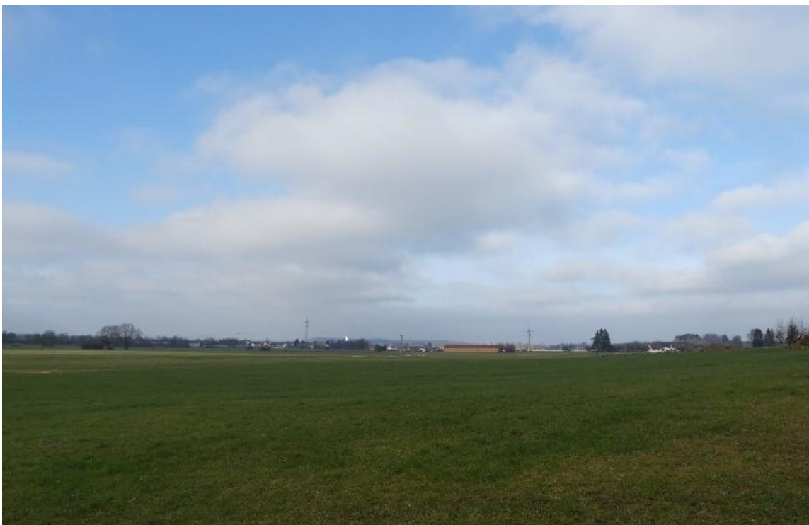
Abbildung 15: Blick vom westlichen Rand des Günztals nach Norden auf den geplanten Dammstandort und Sontheim
