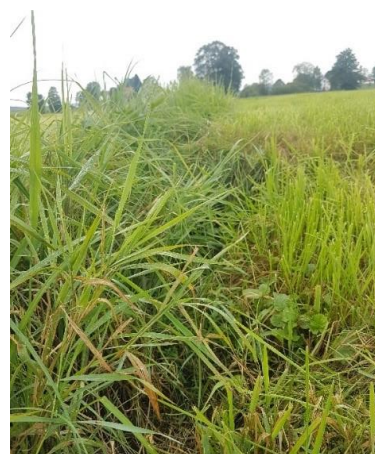
Abbildung 10: Entwässerungsgraben mit ausgetrockneter Sohle
