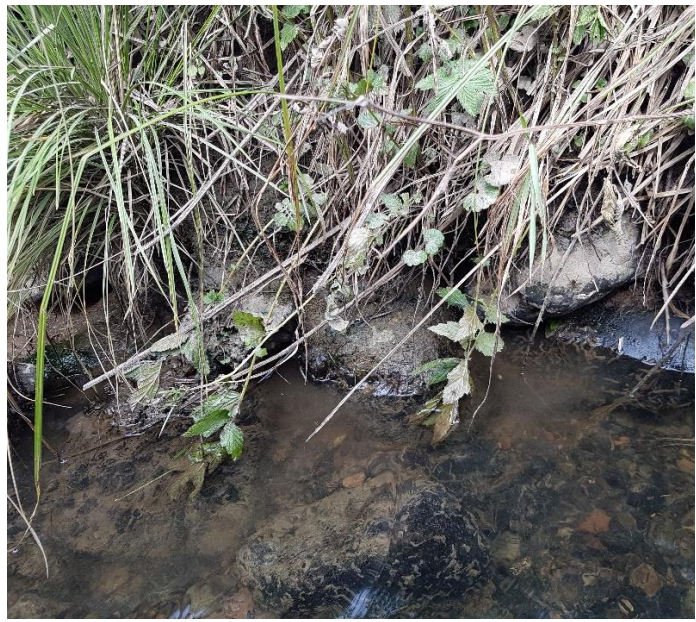
Abbildung 11: Kiesige Sohle und Auskolkungen am Stockerbächlein
