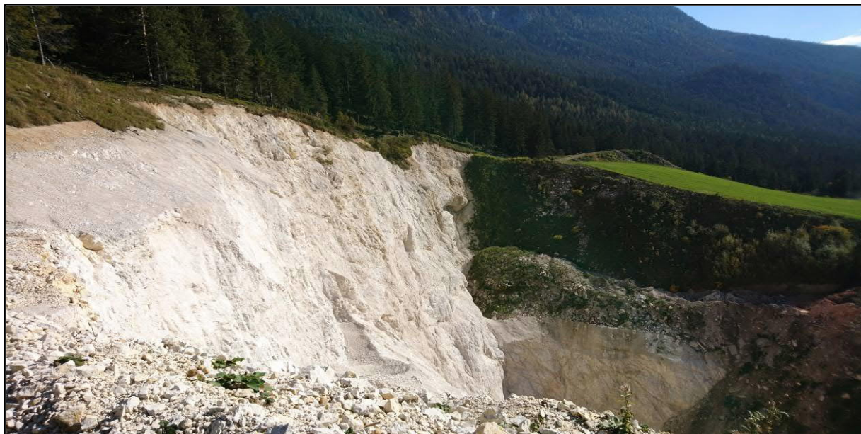
Abbildung 4 Steilwand des Abbaus von Westen aus, Blick nach Südosten, im Hintergrund bereits rekultivierte Flächen
