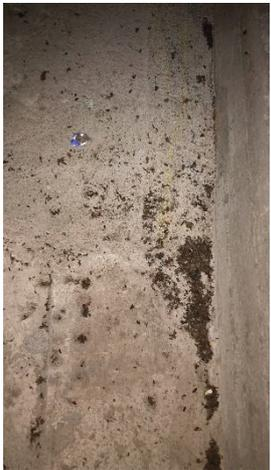
**Abb. 5:** Bsp. Kotspuren im Hohlkasten
