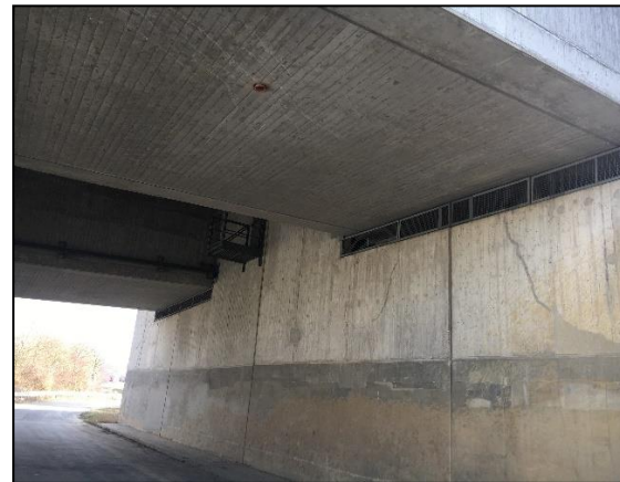
Abb. 13: Außenansicht des südlichen Widerlagers
