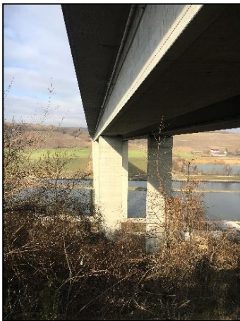
Abb. 12: Außenansicht des südlichen Hohlkastens und der Pfeiler der Brücke Marktbreit
