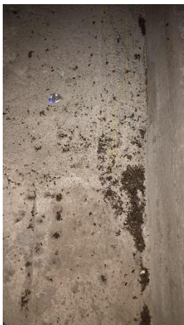
Abb. 5: Bsp. Kotspuren im Hohlkasten
