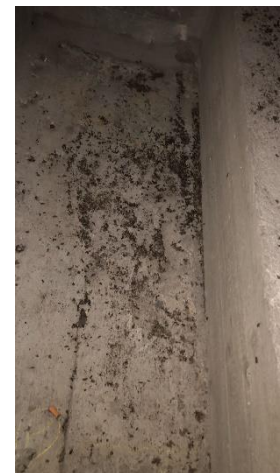
Abb. 8: größere Ansammlung von Kot im westlichen Hohlkasten bei Pfeiler 6
