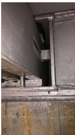
Abb. 21: Bsp.: nicht einsehbare Hohlräume im Widerlager
