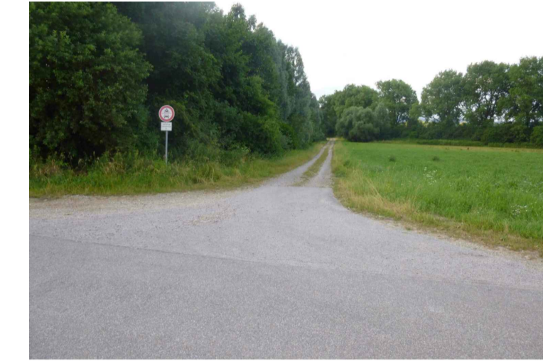
Deichlücke 9: Blickrichtung Nord
