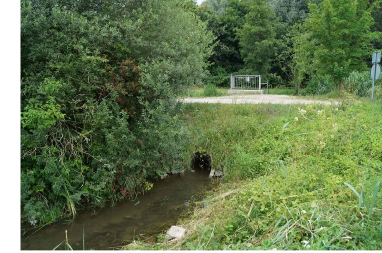
Deichlücke 1: Blickrichtung Nordwest
