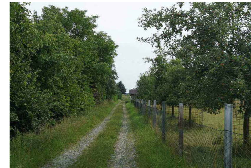
Blickrichtung Süd: Deichabschnitt 3 (ü.d. Sz. I. Zufahrt nach Breitenfeld) bei Station 0+330
