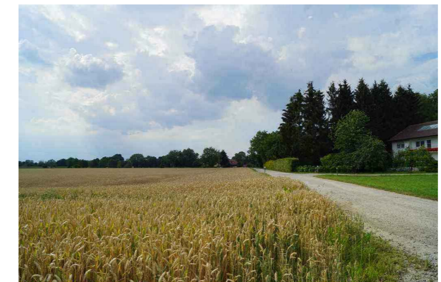
Blickrichtung Nordwest: Deichabschnitt 3 (Ringdeich Breitenfeld) bei Deich-km 0+010
