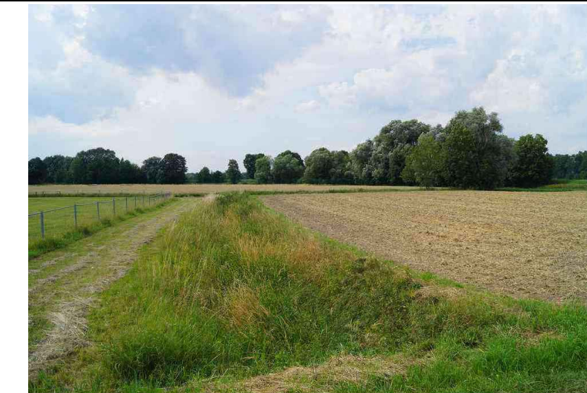
Blickrichtung Nordwest: Deichabschnitt 3 (Ringdeich Breitenfeld) bei Deich-km 0+260
