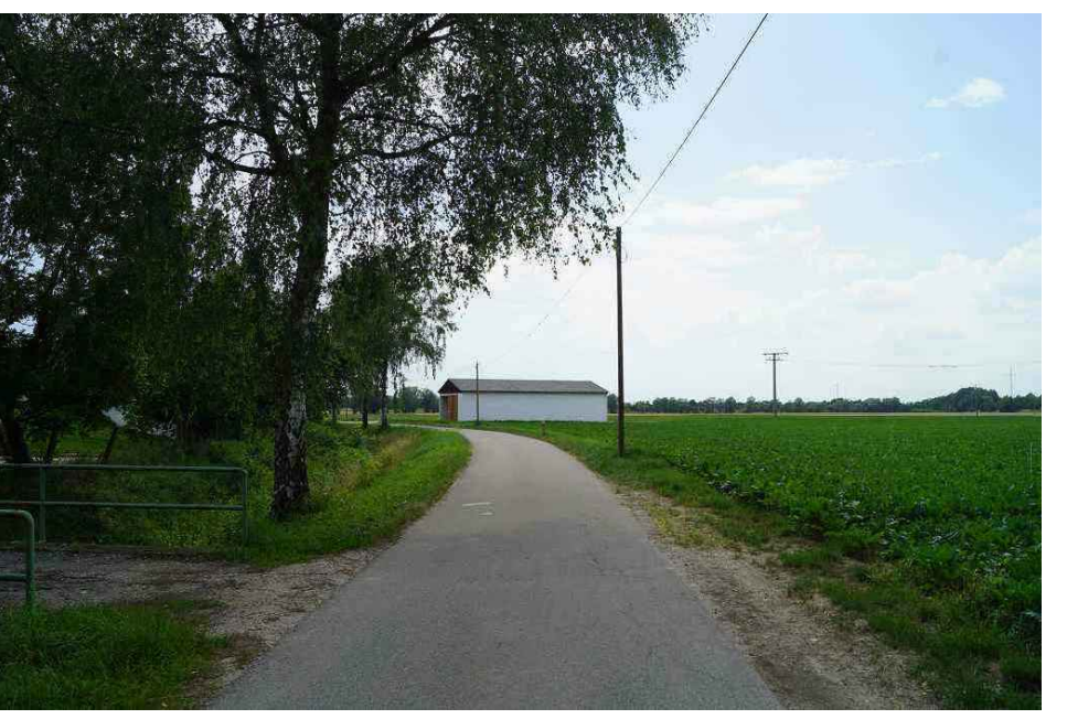
Blickrichtung Südwest: Deichabschnitt 3 (Ringdeich Oberau West) bei Deich-km 2+400
