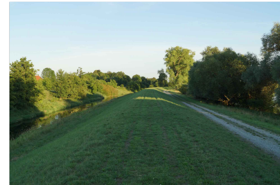
Blickrichtung Südost: Deichabschnitt 2 bei Deich-km 3+900
