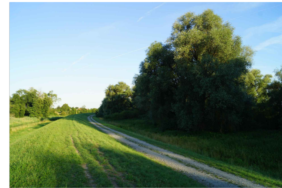
Blickrichtung Südost: Deichabschnitt 2 bei Deich-km 3+350
