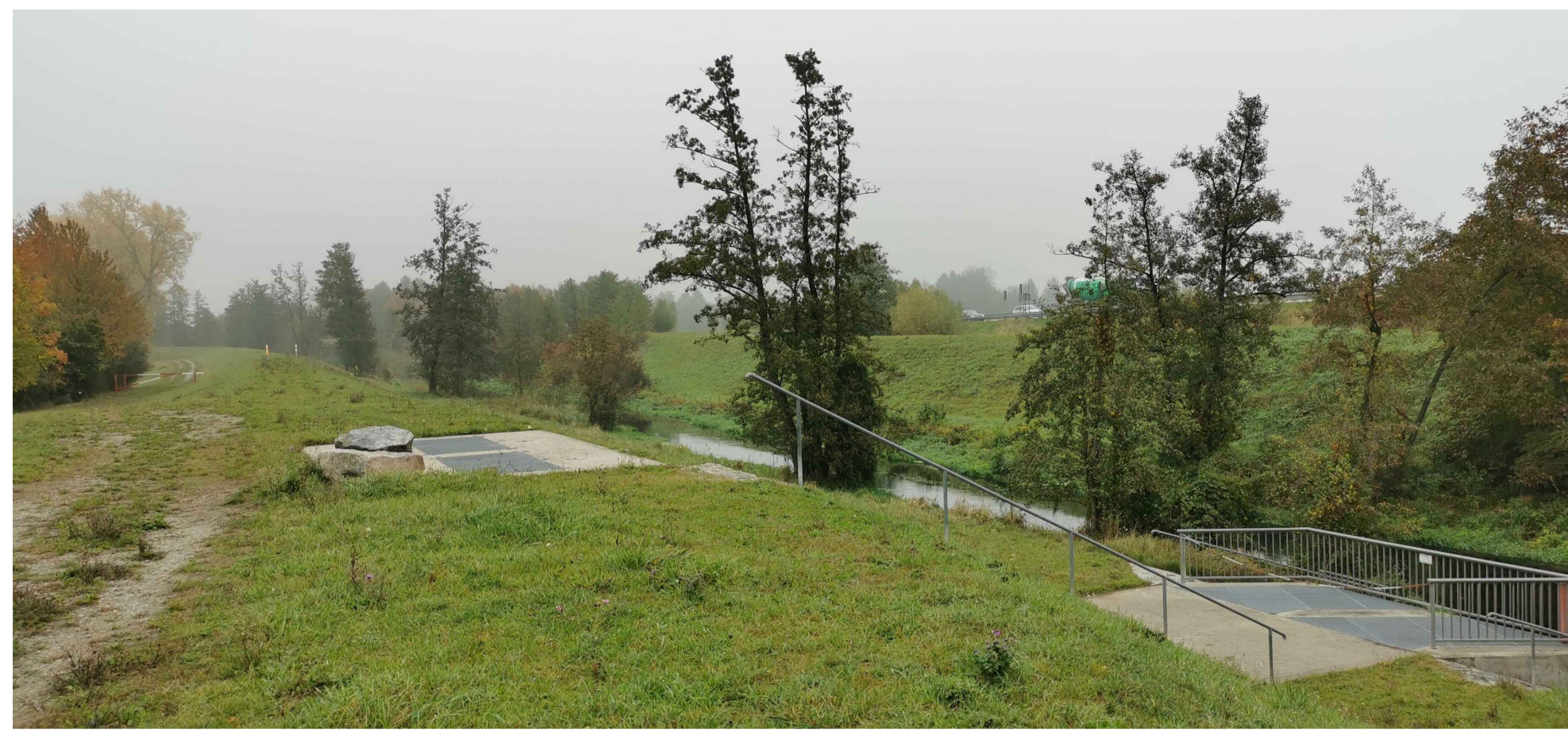
Blickrichtung Nordost; Regulierungsbauwerk zur Kößnach (RzK), Auslauf- und Schachtbauwerk
