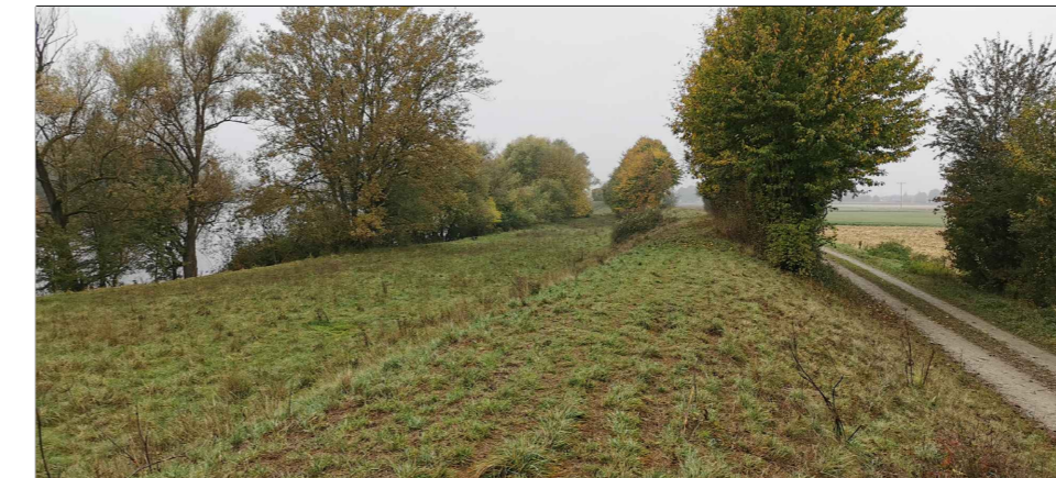
Blickrichtung Nordwest: Deichabschnitt 1 bei Deich-km 2+300
