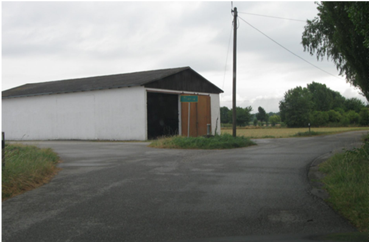
Abbildung 11: Blickrichtung Norden: Bereich der geplanten Deichscharte
