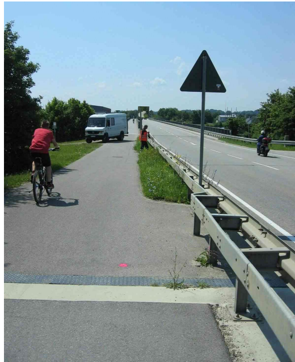
Abbildung 1: Blickrichtung Süden: Bereich SRs 48 / Radweg, Höhe Anbindung an Kagerser Brücke
