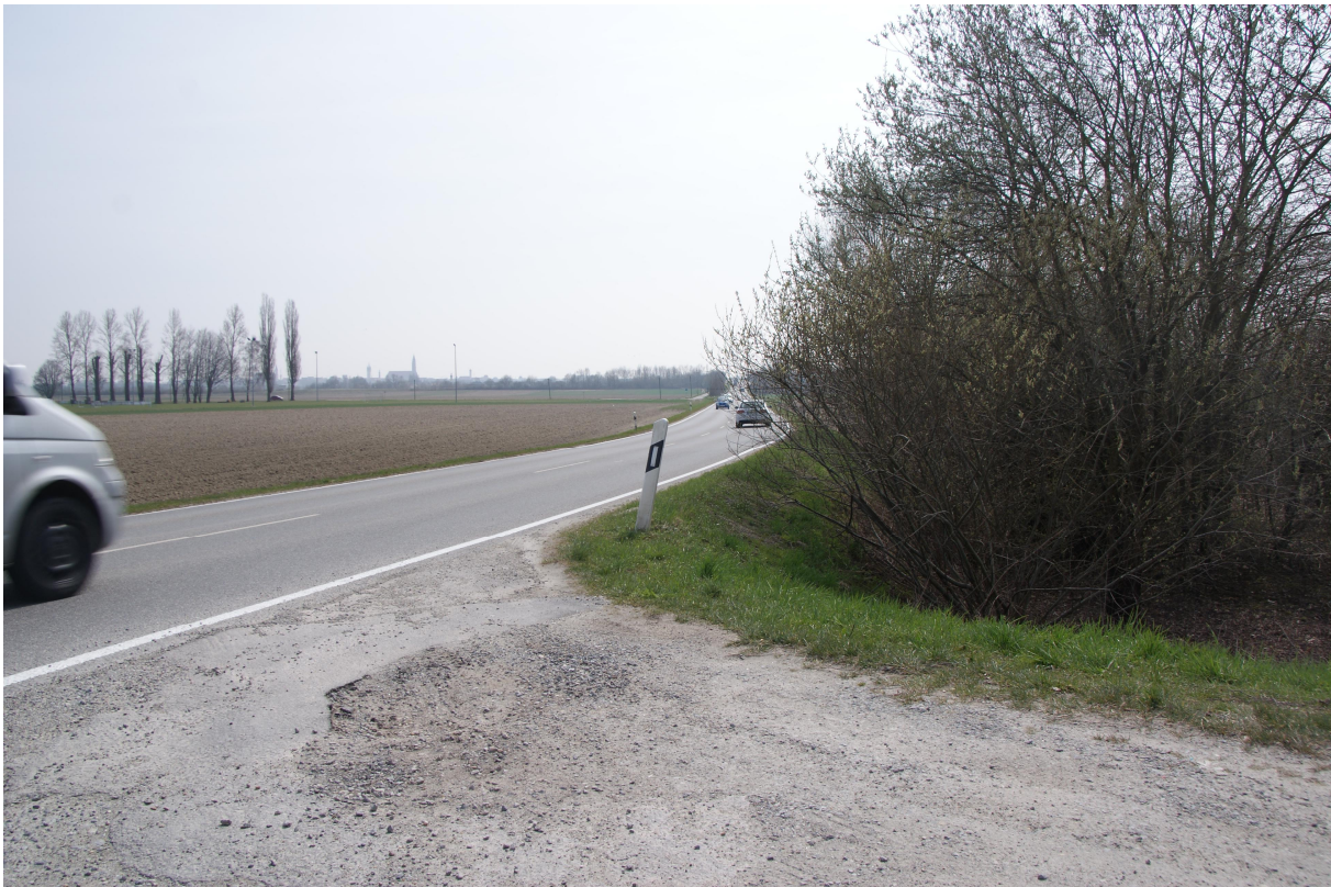
Abbildung 6: Blickrichtung Süden: Bereich SRs 48, Abfahrt zum Auslaufbauwerk
