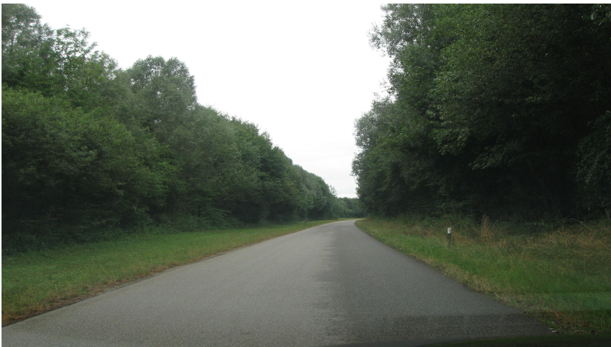
Abbildung 8: Blickrichtung Westen: Zufahrt nach Öberau, Bereich östlicher Beginn der Anhebung
