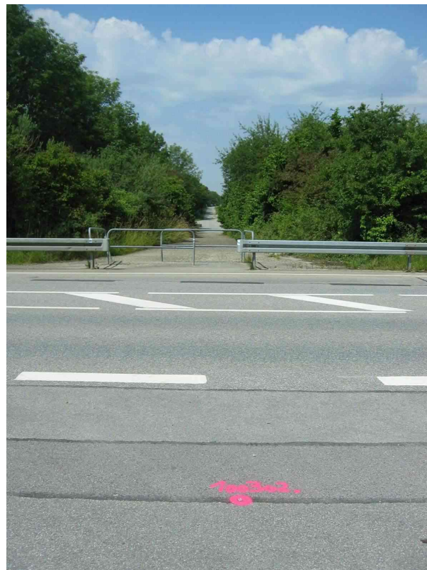
Abbildung 2: Blickrichtung Westen: Bereich SRs 48, Anbindung Radweg
