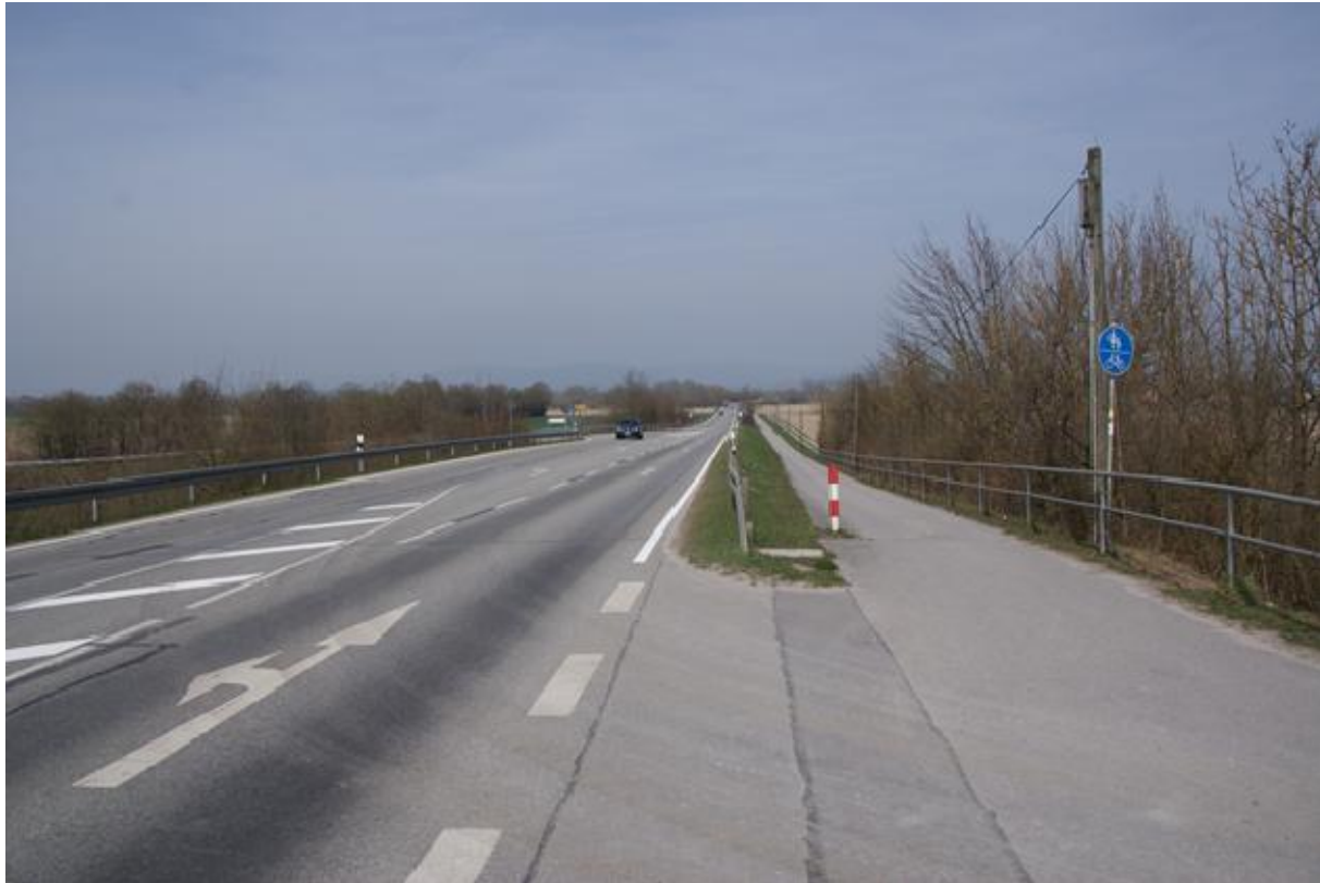
Abbildung 3: Blickrichtung Norden: Bereich SRs 48, ca. Beginn der Baustrecke
