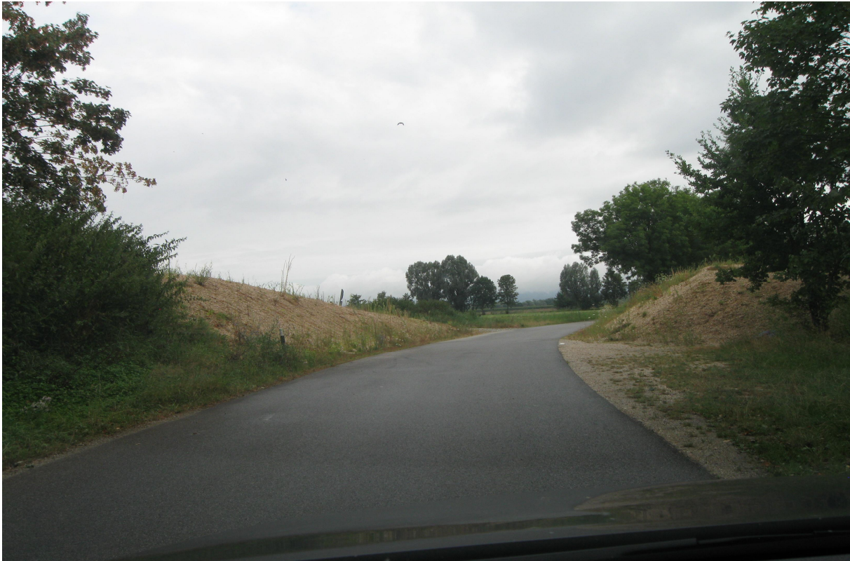
Abbildung 9: Blickrichtung Norden: Zufahrt nach Öberau, Bereich Durchschneidung ehemaliger rechter Donaudeich südlich des stillgelegten Schöpfwerks Öberau
