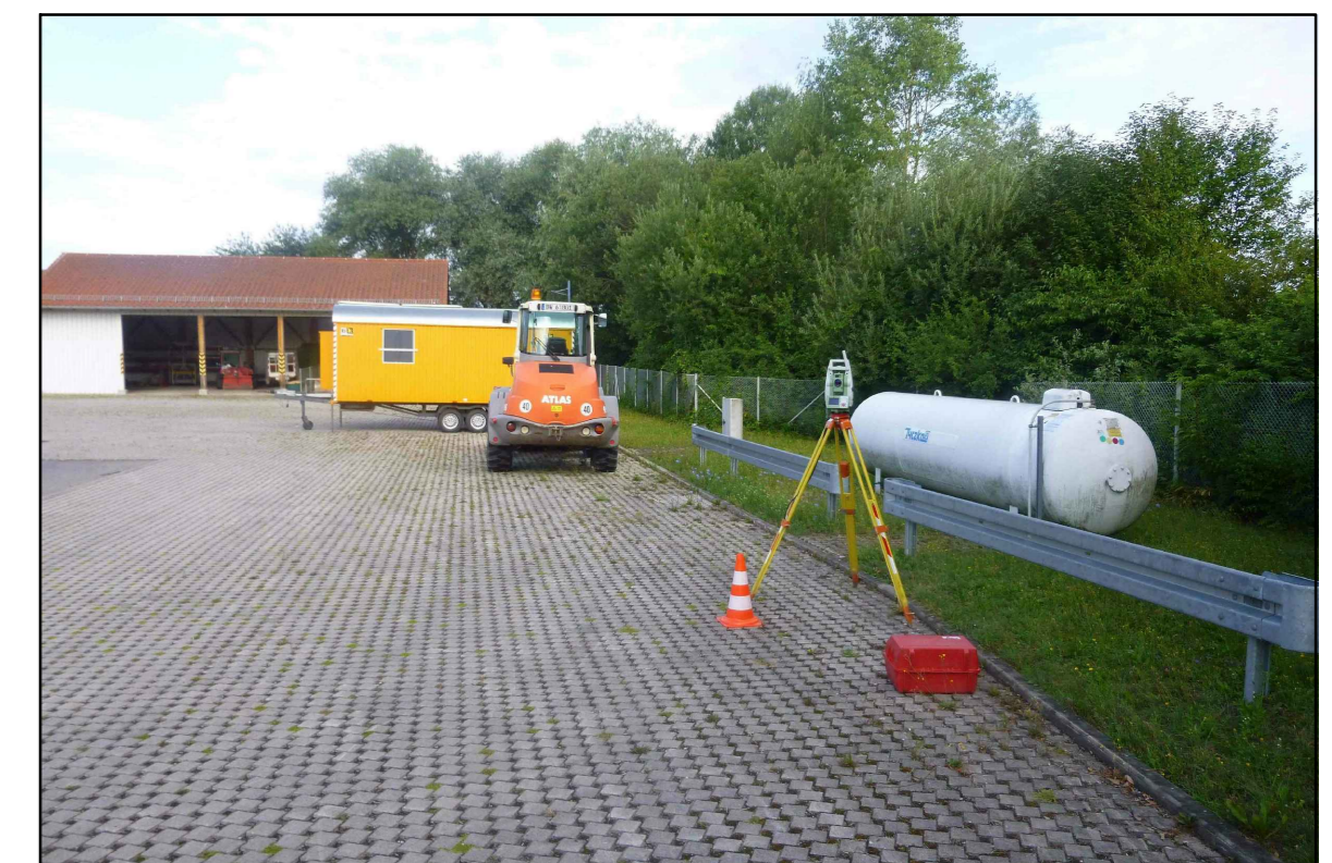
nördliche Grundstücksgrenze des Betriebsgeländes der WSV
