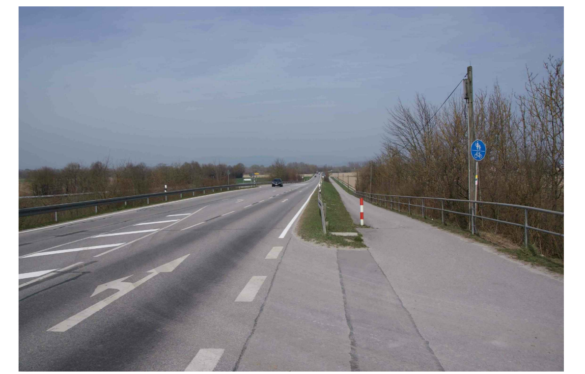
Westtangente (aktuelle SRs 48, Blickrichtung Norden)
