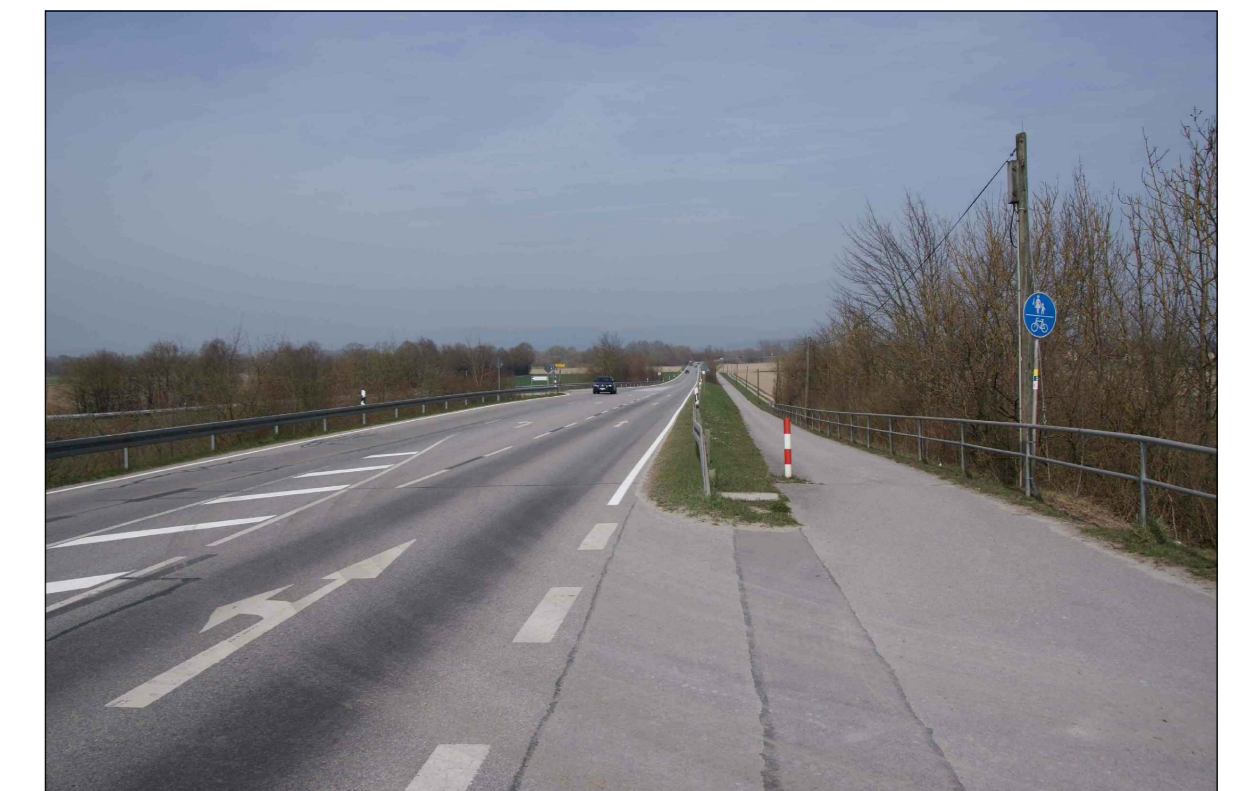
Westtangente (aktuelle SRs 48, Blickrichtung Norden)
