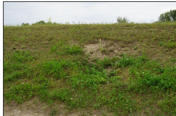
Abbildung 17: Beispiel Wurzelkrater auf dem linken Donaudeich bei Deich-km 5+300
