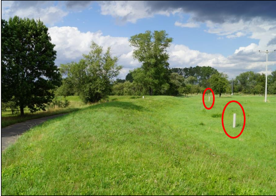
Abbildung 2: Deichanlage mit Deichschutzstreifen und Abgrenzungsmarkierung
