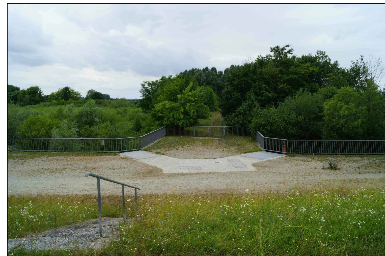
Blick nach Nordosten vom bestehenden Regulierungsbauwerk auf den Trenndamm
