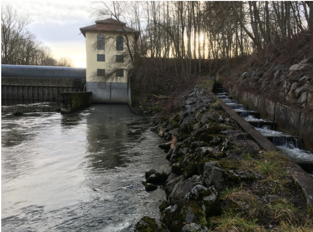
Abbildung 8: Blick vom UW auf Auslauf KW und best. technischen Fischpass
