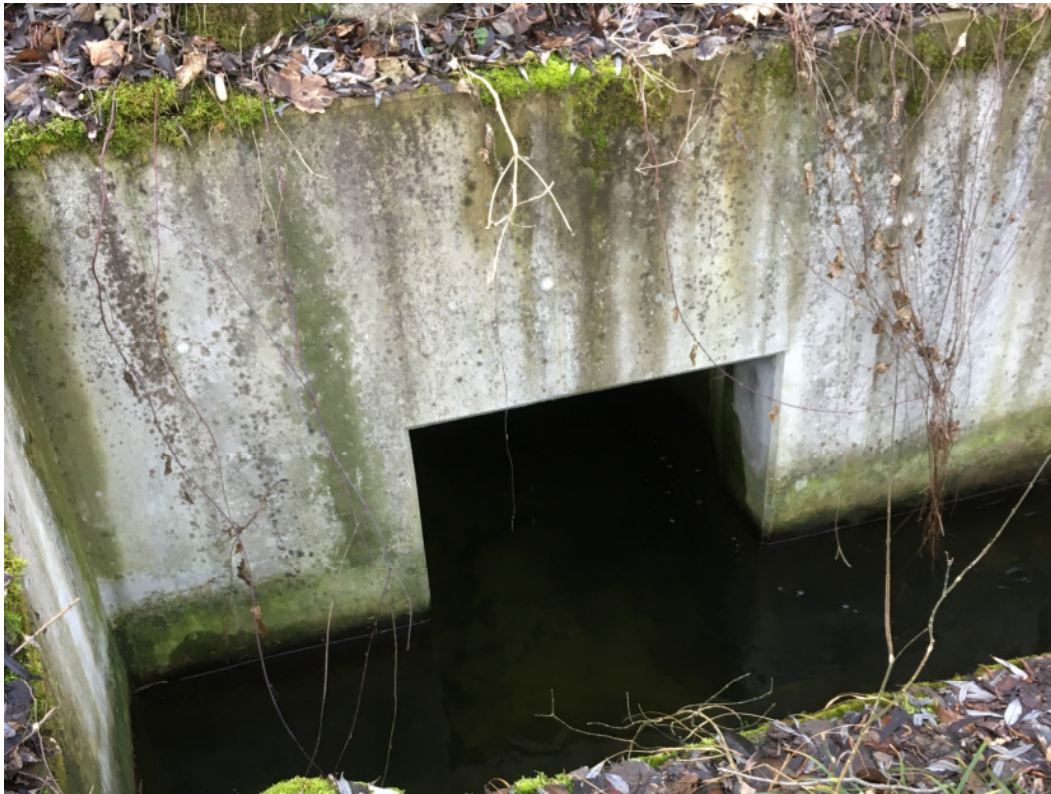
Abbildung 6: bestehender Durchlass: Auslauf = Beginn technischer Fischpass
