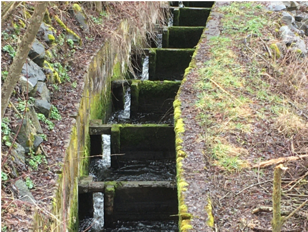
Abbildung 7: bestehender technischer Fischpass, Blick vom Oberwasser
