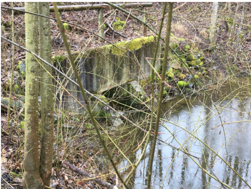
Abbildung 5: bestehender Durchlass: Einlauf = Ende naturnaher Fischpass
