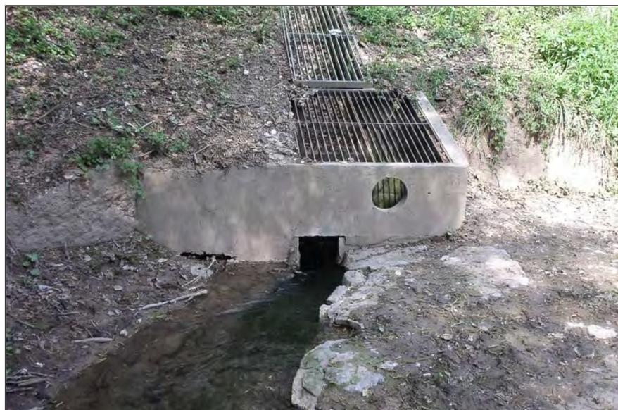
Abbildung 7: Einlaufbereich des bestehenden Rückhaltebeckens
