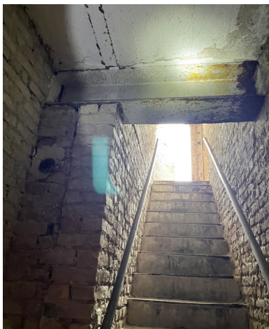
Auflagerpunkt Stahlträger über Kellerausgangstreppe
