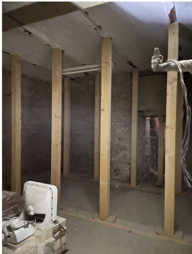
Provisorische Notabstützung der Kappendecke im UG
