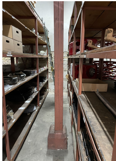
Mittelstütze Haupttragwerk, Stütze mit Betonsockel
