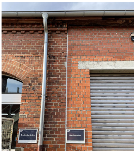
Dachrand mit gemauertem Schmuckband
