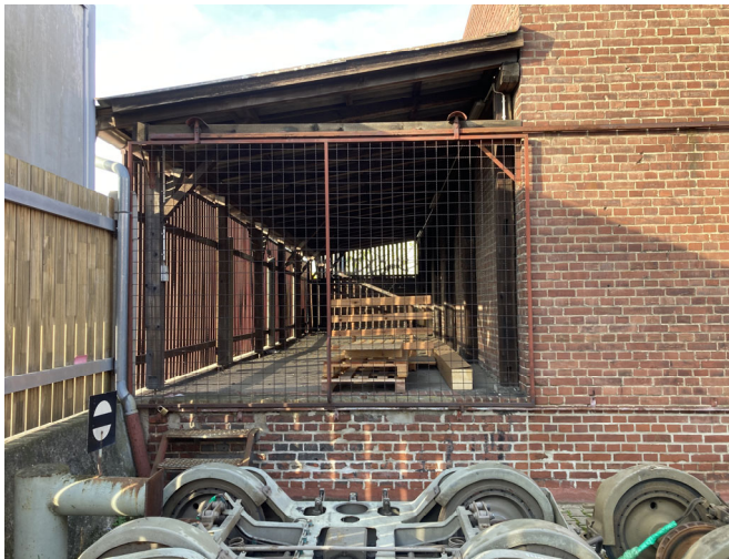
Außenlager, überdacht, Holzkonstruktion mit Wellplattendeckung
