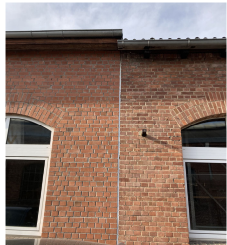
links komplett erneuerte Klinkerfassade, Formatwechsel
