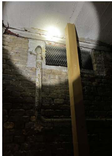
Provisorische Notabstützung der Kappendecke im UG
