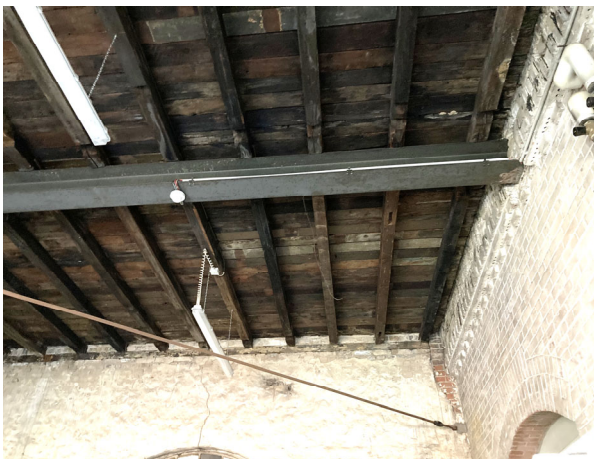
Diagonalverspannung Stahl, Mittelträger Stahl
