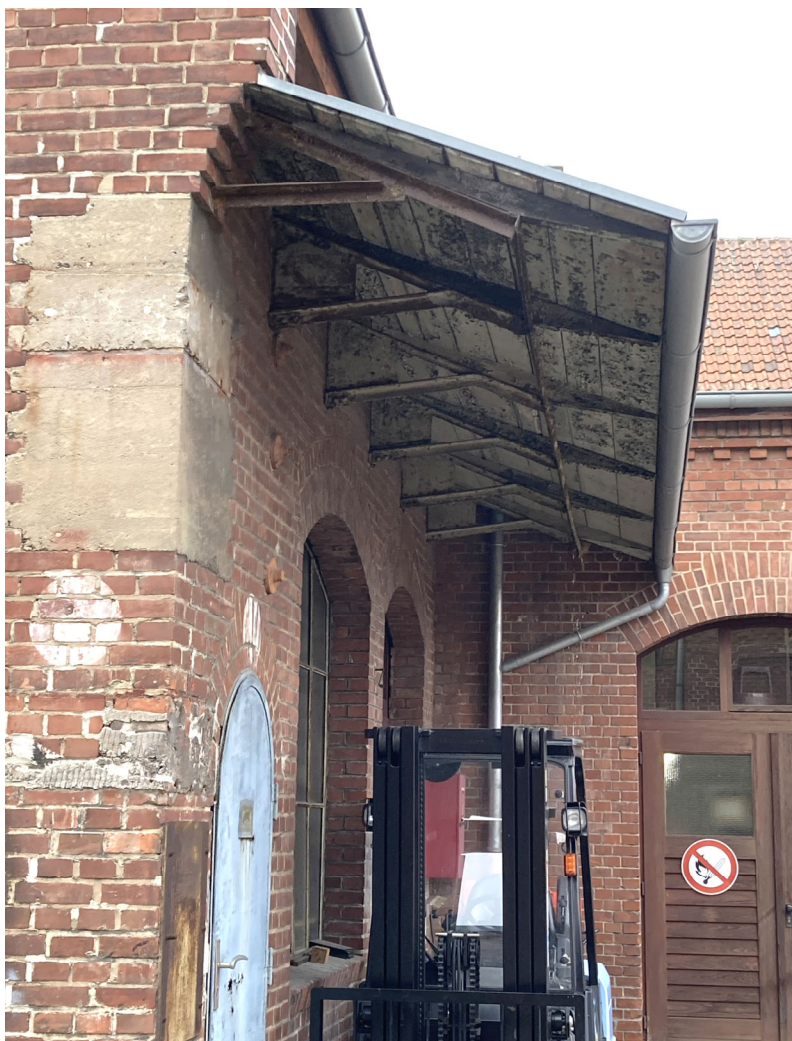
Teilansicht Norden, Vordach, Stahlkonstruktion mit Brettschalung
