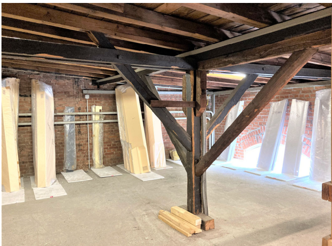
Mittelstütze Haupttragwerk
