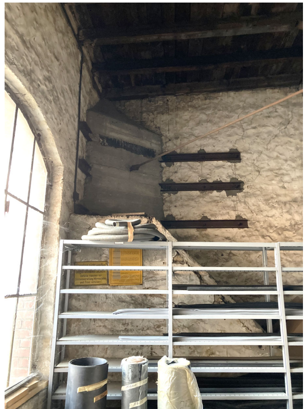
unten Kellerabgang (Zugang von außen) oben Gebäudeaussteifung durch betonverstärkte Eckausbildung, Flachstahlband und Diagonalverspannung
