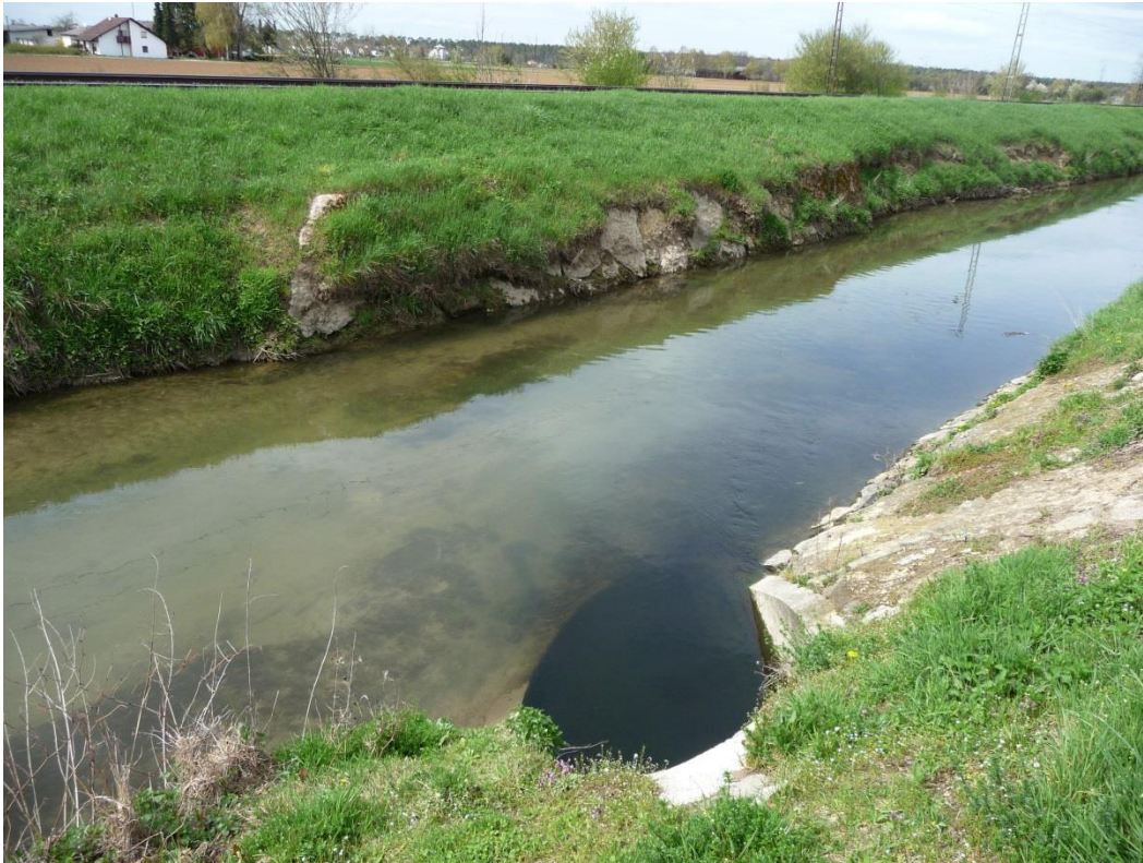
Foto 9: Einleitung der Kläranlage Wiesloch auf der rechten Seite des Leimbachs. Blick nach Nordwesten in Fließrichtung auf einen Dammbereich, die Bahnlinie, Ackerflächen und Gebäude eines landwirtschaftlichen Gehöfts.
