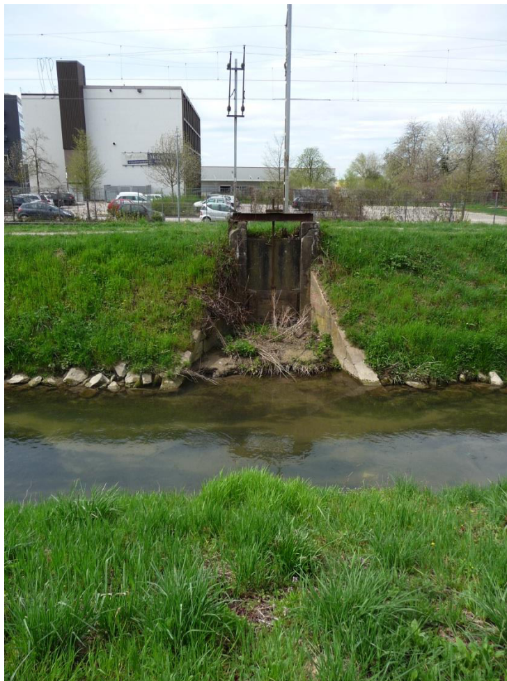
Foto 2: Altes Schützbauwerk. Blick nach Osten auf das Impex-Gelände
