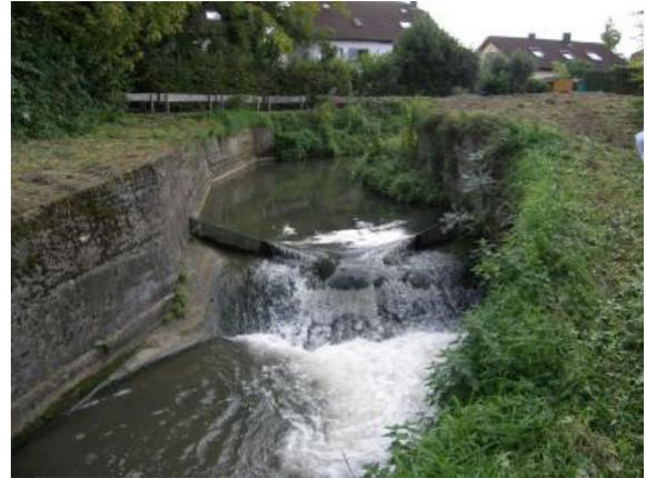
**Bild 4:** Absturz in Nußloch: Im Rahmen der Ausbaumaßnahme wird der Absturz ökologisch durchgängig gestaltet (Blick in Richtung oberstrom; km 19+345).
