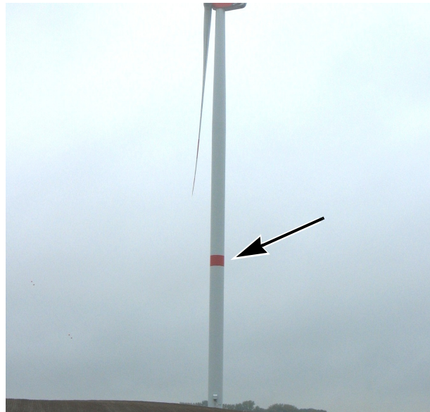
Abb. 4 Roter Farbring an Anlage mit Gesamthöhe >150 m
