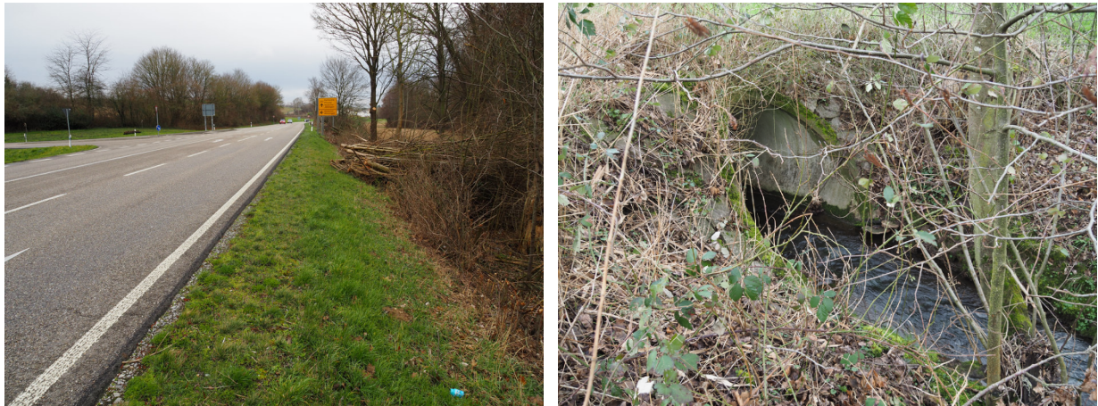
Bilder 4: Entwässerungsabschnitt B4
