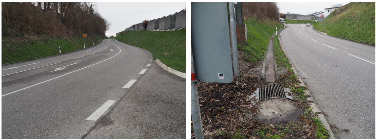
Bilder 2: Entwässerungsabschnitt B2 Bereich Einmündung Baugebiet Gageneck
