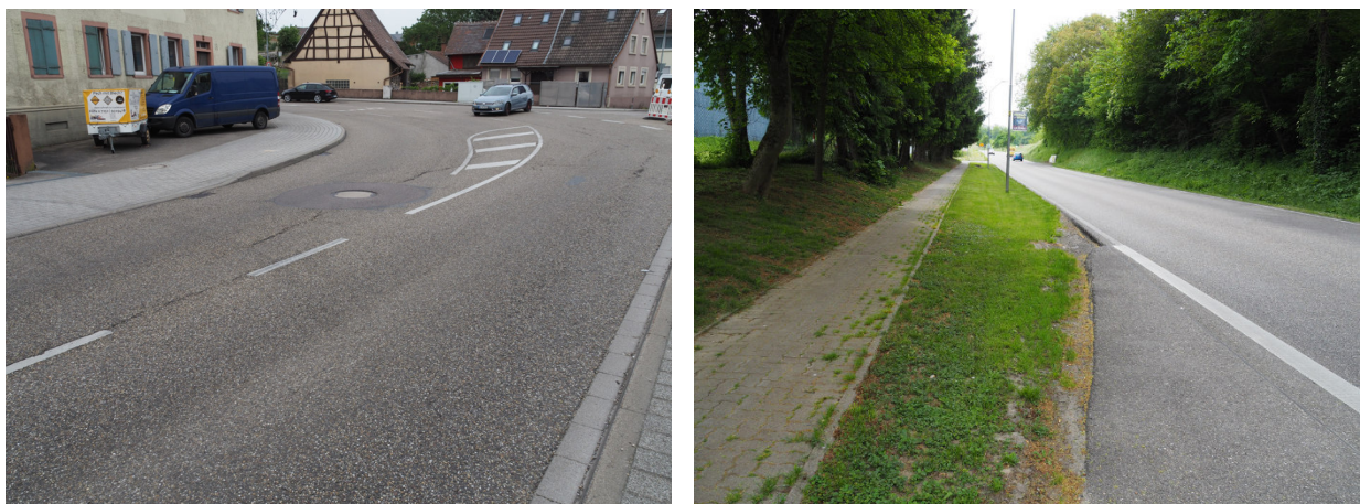
Bilder 3: Entwässerungsabschnitt B3 mit Einmündung L 559 + Ortsausgang Ri. Bretten
