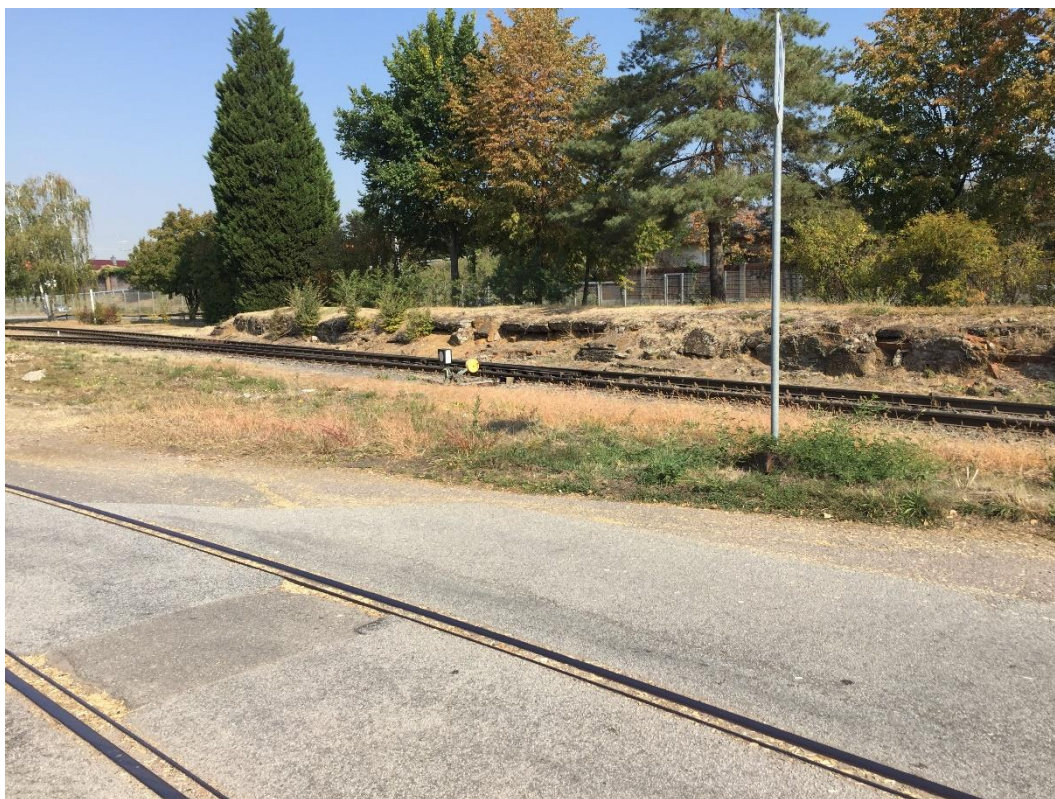
Abbildung 9. Mauereidechsenlebensraum an Mauerresten nahe der Frankenthaler Straße.
