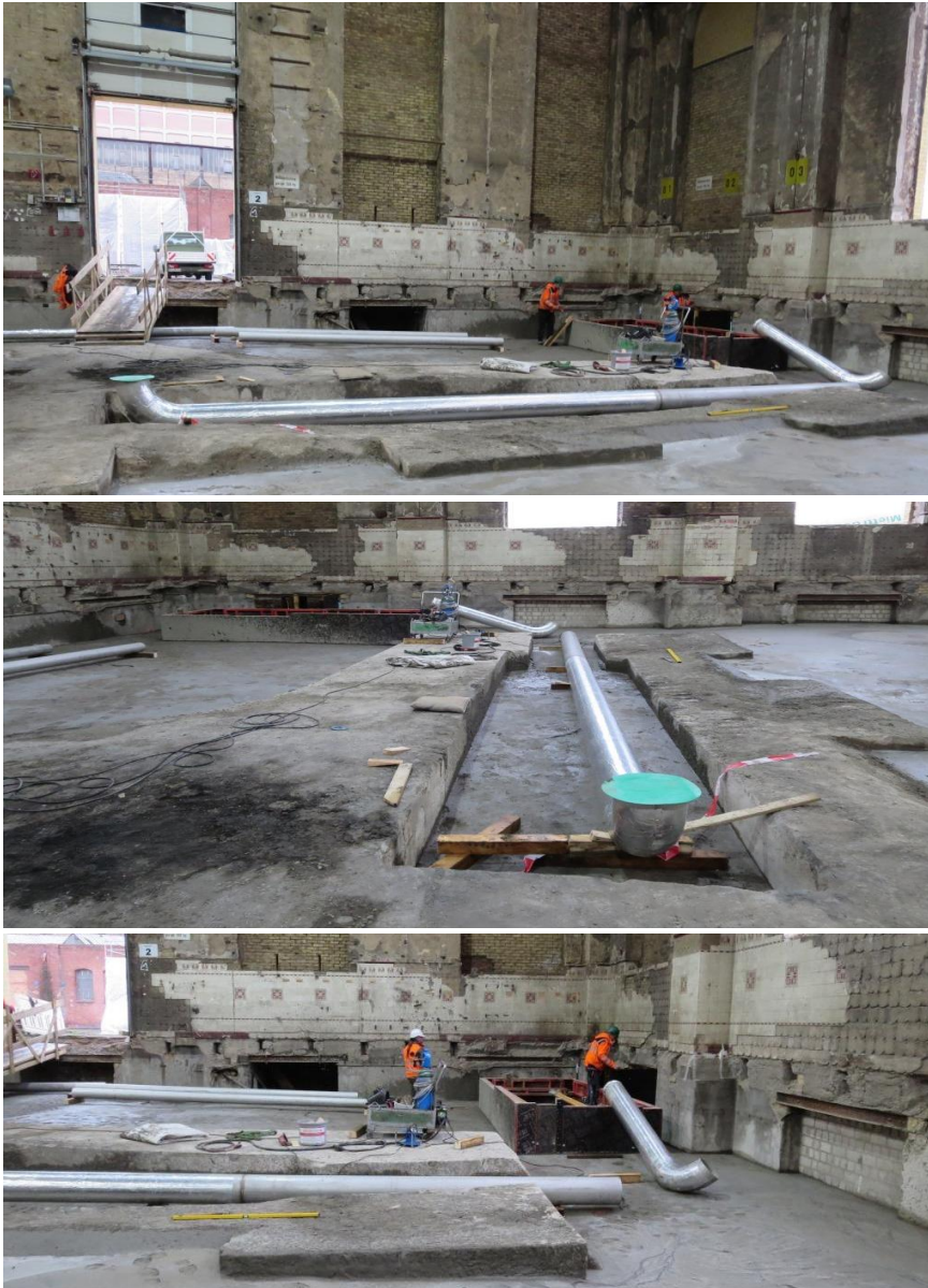
Bild 11 bis 14: Vormontage der Rohrleitung DN 300 zur Entwässerung der Hauptrinne zum Auffangschacht
