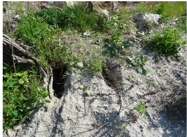
Dto., andere Seite des Haufwerks. Hier wurde offensichtlich zu viel Sand aufgeschüttet.
