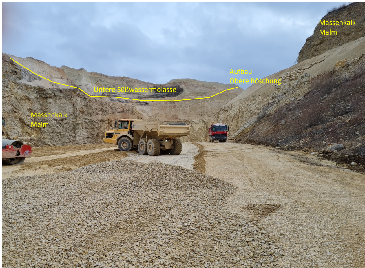
Abb. 1: Blick nach Südwesten zur westlichen Abbauwand, bestehend aus Massenkalk mit den auflagernden Schluffen, Tonen und Mergeln der Unteren Süßwassermolasse.
