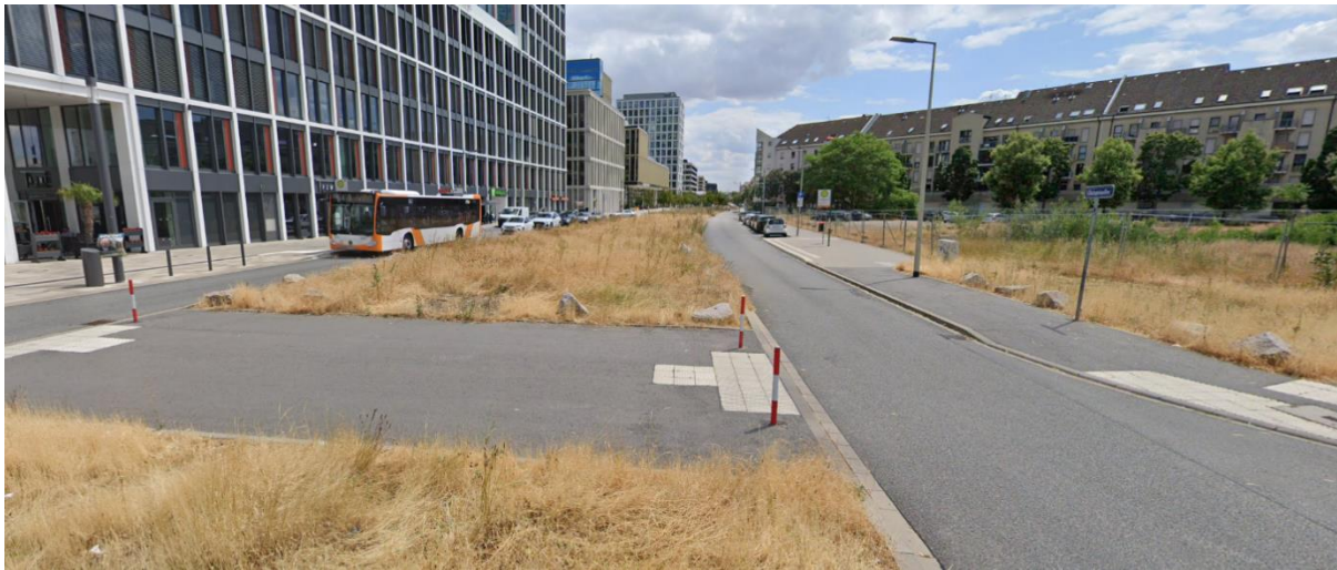
Abbildung 2: Freihaltetrasse Abschnitt 1, "Glücksteinallee", Blickrichtung nach Osten
