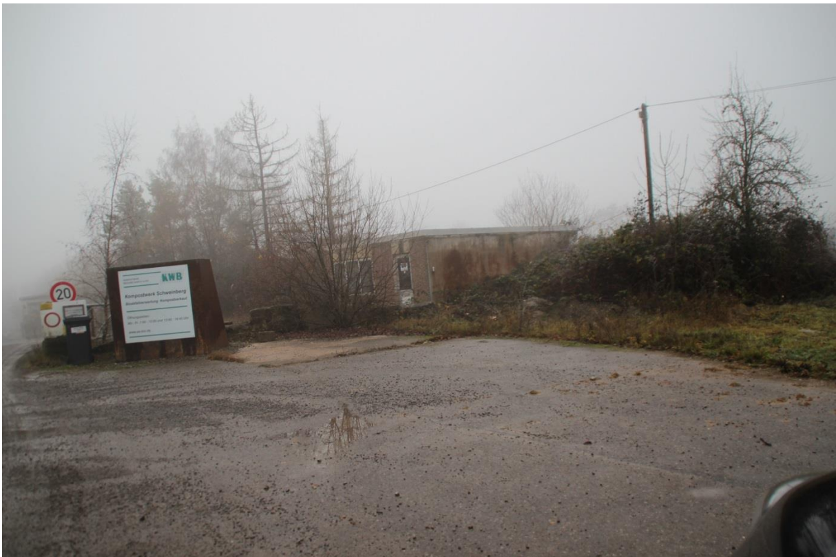
IP B: Pförtnergebäude KWB Kompostwerk Bauland GmbH & Co. KG Königheimer Str. 100, Hardheim-Schweinberg
