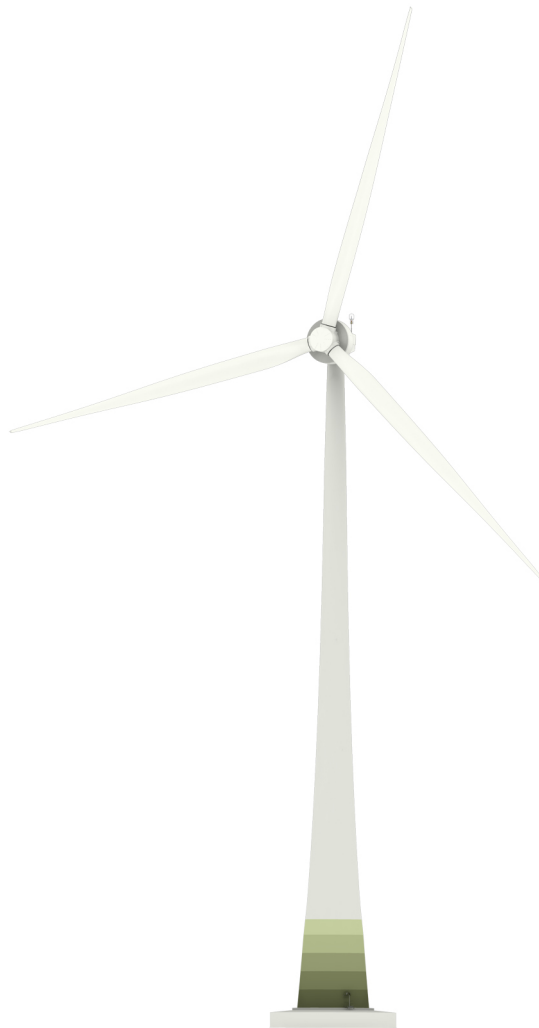
Abb. 1: E-138 EP3 E2 Gesamtansicht
