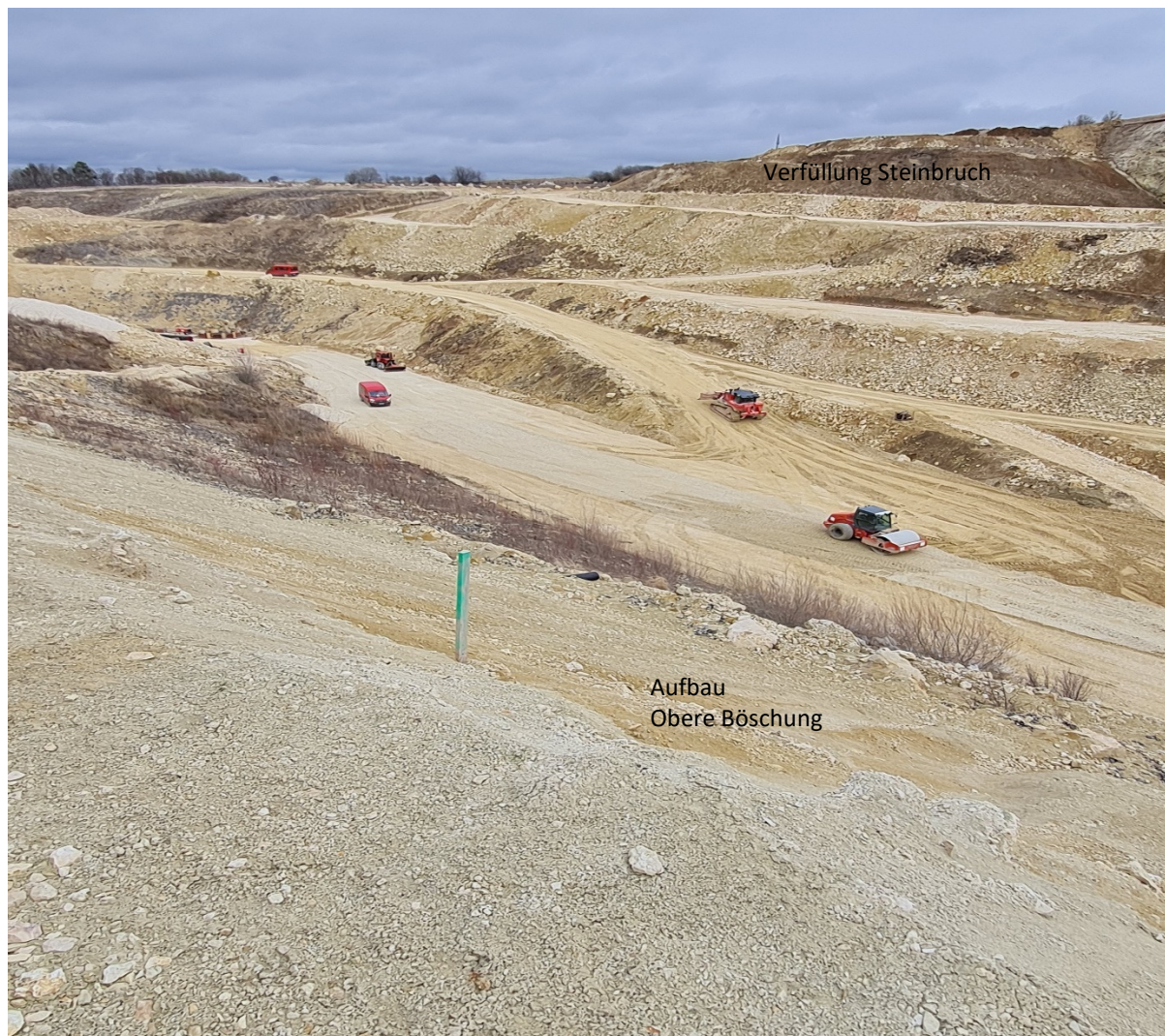
Abb. 3: Blick nach Osten zum Verfüllbereich
