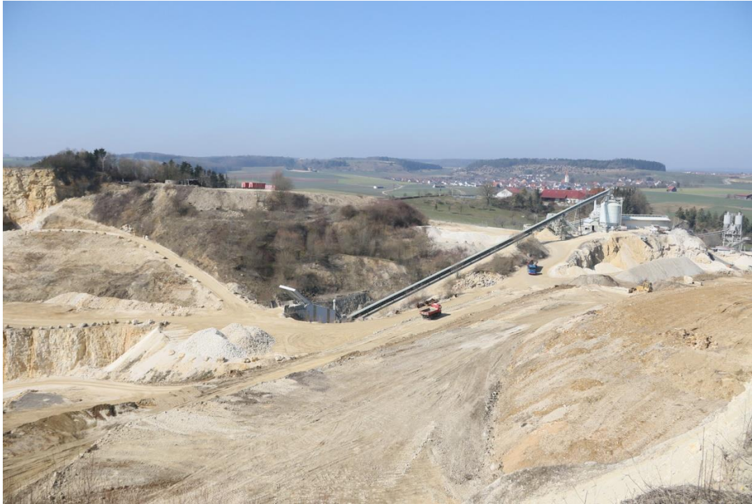
Abbildung 15: Werksanlagen des Steinbruchs und angelegte Fahrwege
