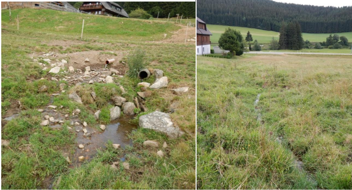
Abbildung 8: Verrohrter Abschnitt des Steinbachs und sein weiterer Verlauf durch eine Weide unterhalb der Maßnahmenstrecke.
