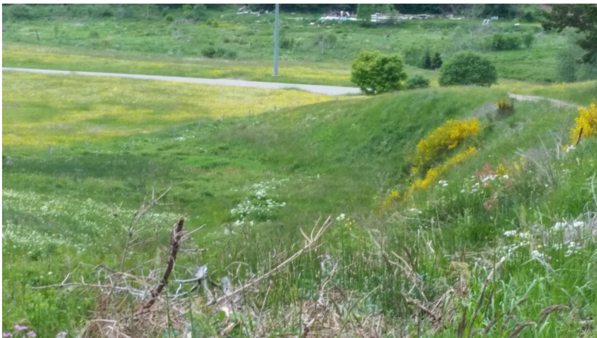
Abbildung 23: Die Böschung südlich des Weges im Gewann „Im Gründle“ sollte durch den Ausbau nicht beeinträchtigt werden.
