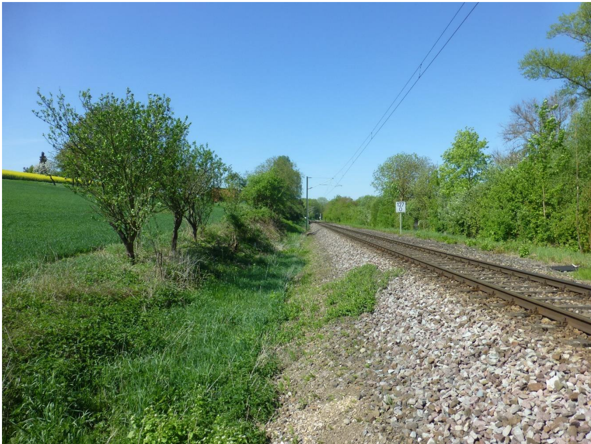
Abb. 2: Blick entlang der aktuellen betriebenen Strecke
