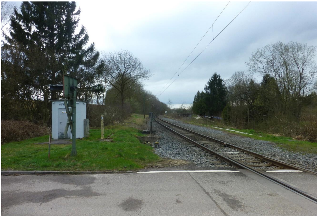
Abb. 5: Bahnübergang bei Bahn-km 127,3, Blickrichtung West.
