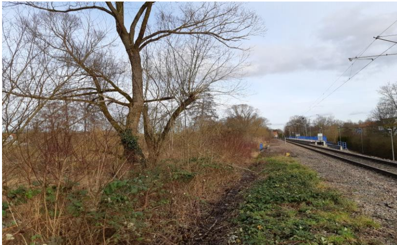
Abb. 6: Lage des zusätzlichen Bahnsteigs Schwaigern Ost, Blickrichtung Heilbronn.
