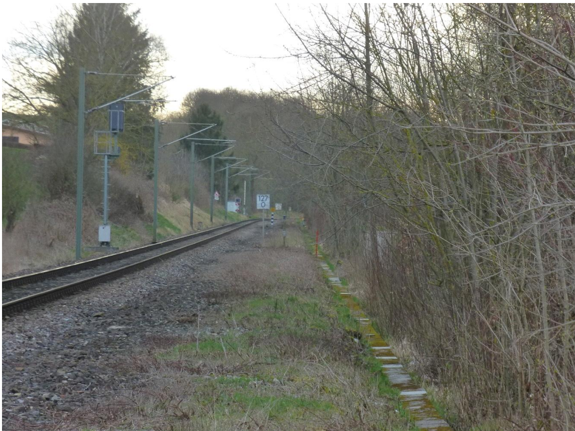
Abb. 4: vorhandener Erdkörper der ehemaligen Zweigleisigkeit.
