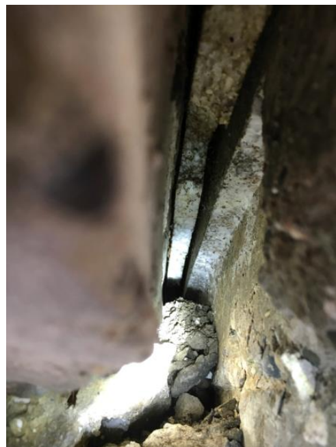
Abb. 31: Bauwerk 5 – ursprünglich mit Styropor gefüllte Spalten; aktuell tiefer Hohlraum (ca. 50 cm) durch herausgekratztes Füllmaterial
