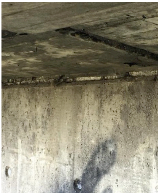
Abb. 30: Bauwerk 5 – mit Styropor gefüllte Spalten, zum Teil herausgekratzt oder angefressen (vermutlich Nagetiere)
