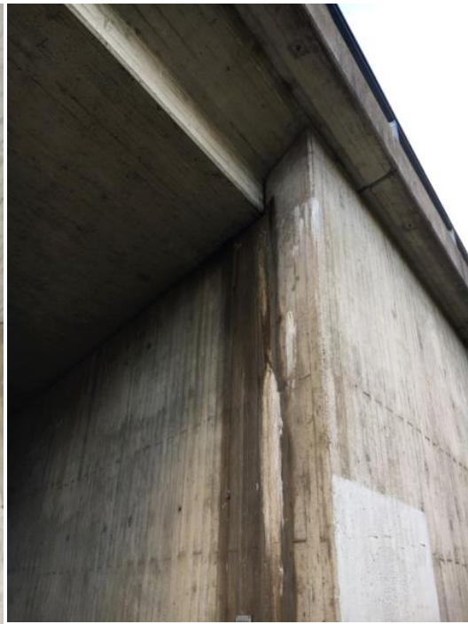
Abb. 29: Bauwerk 1 – Spuren von abfließendem Regenwasser aus den Spalten entlang der Brückenwiderlager
