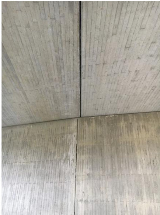
Abb. 28: Bauwerk 1 – Dehnungsfuge zwischen den Fahrbahnen
