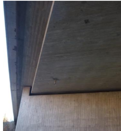
Abb. 17: Überführungsbauwerk mit Dehnungsfugen südwestlich von Rückertsbronn
